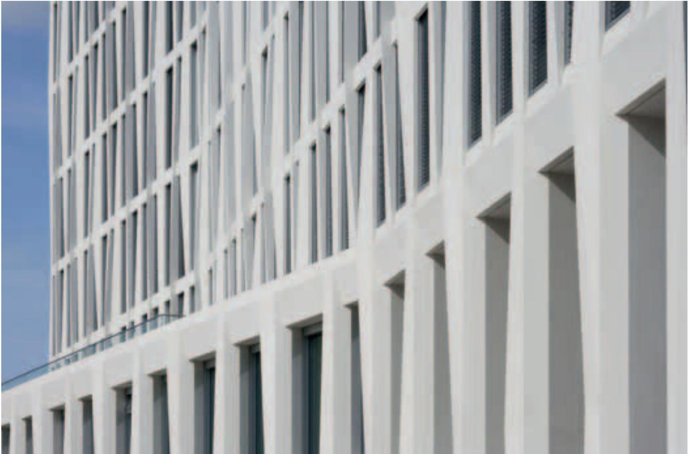
Die Fassade der 17-geschossigen Deutschlandzentrale des Mineralölkonzerns Total ist keine normale Architekturbetonfassade. Allein im Erdgeschoss und dem ersten Obergeschoss gibt es über 80 verschiedene Elementvarianten, die es planerisch und technisch zu durchdringen galt, um die höchst anspruchsvollen Anforderungen erfüllen zu können.
