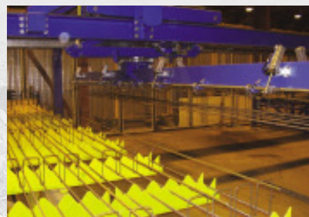
第 21 页 混凝土多孔板的自动化配筋
