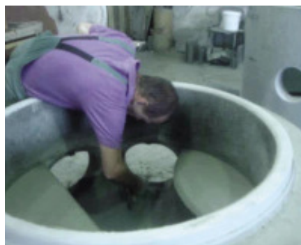
图4 手工操作修饰人孔构件的管道口
