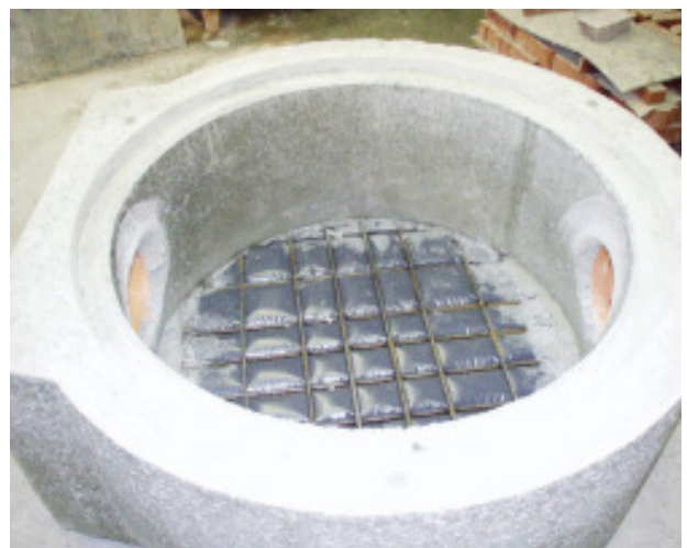
图3 准备好可以安装管道的人孔原坯底部
