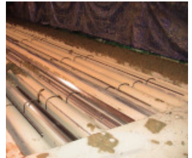
图13 钢筋笼放在位于生产托板上的抽芯管模之上
