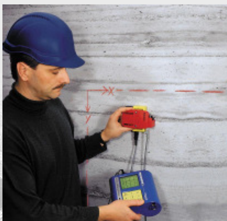
第 19 页 在施工过程中检验钢筋混凝土的保护层
