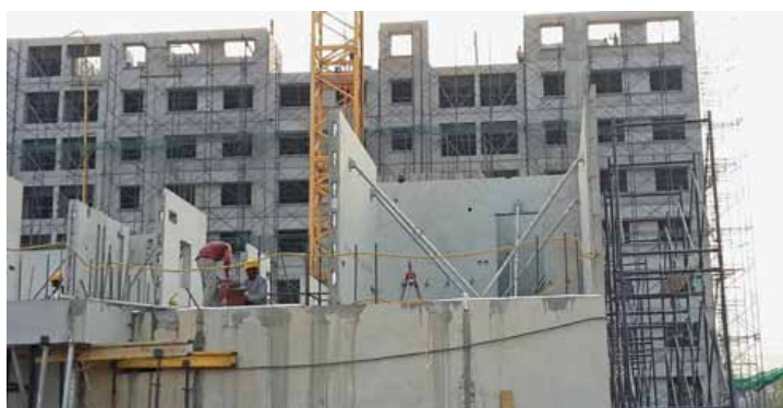
Elementos ya instalados en un gran proyecto de construcción en la India Elemento totalmente instalado em um grande projeto de construção na Índia
