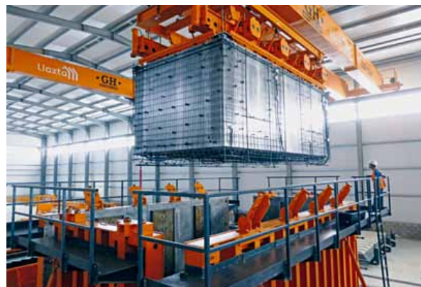
Refuerzos, instalaciones, conexiones de agua y electricidad son preparados en el núcleo modular y después insertados en el encofrado externo
