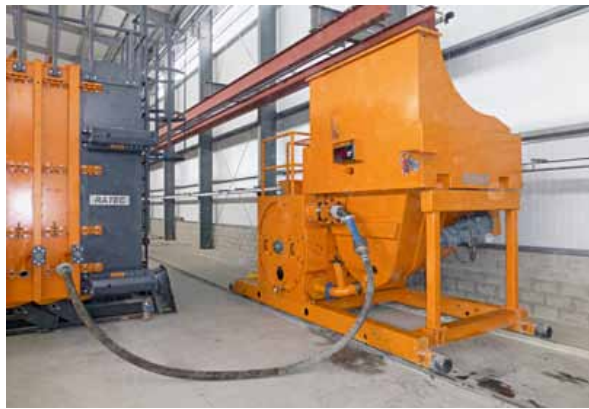
Conexión de la bomba para el encofrado para el llenado con concreto desde abajo
