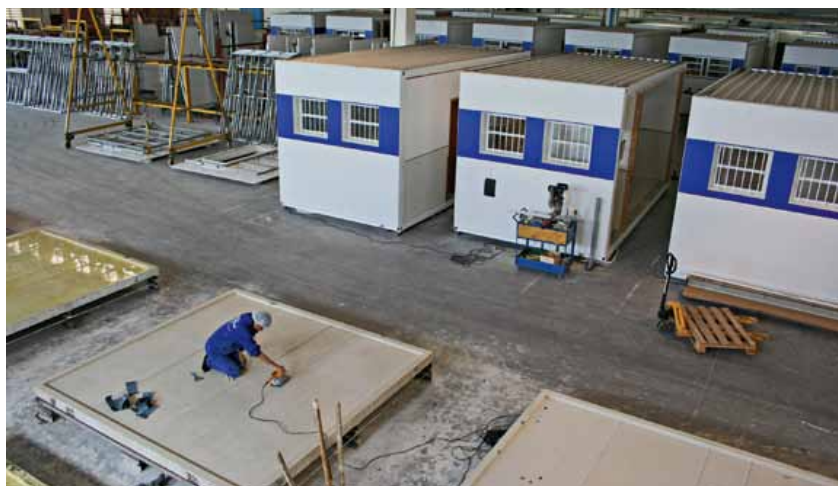
Mientras en la zona delantera de la nave ya se preparan los moldes para el siguiente hormigonado, en la parte posterior, los módulos de contenedor Fastflex terminados esperan a ser entregados
