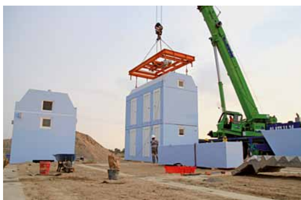
Montaje final en el sitio de la obra
