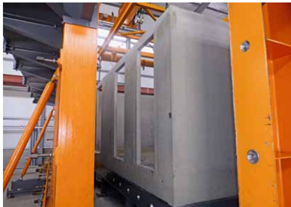
El núcleo modular es removido posteriormente al curado de los elementos y, enseguida, el encofrado externo es abierto ...
