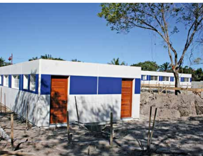
Los contenedores se van alineando en obra, aquí en una futura comisaría de policía cerca de Praia do Forte/BA, en función del tamaño proyectado del objeto
