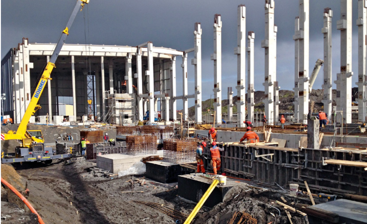
La construcción del edificio para el almacenamiento de equipos
