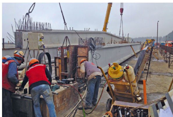
Curado final de las vigas
