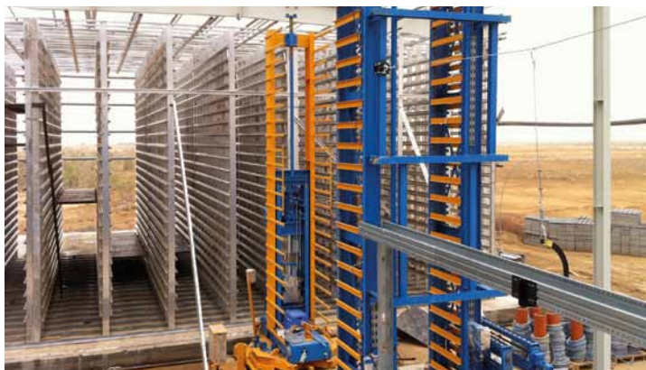
Montaje de la cámara de fraguado HS-Alu-Premium Montagem da câmara de cura HS-Alu-Premium
