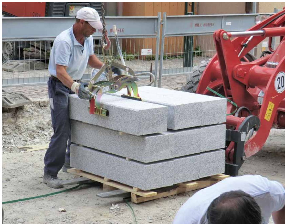
El manipulador de bloques Easygrip EXG tiene una abertura de agarre de 0 a 300 mm O manipulador de blocos Easygrip EXG tem uma abertura de agarre de 0 a 300 mm
