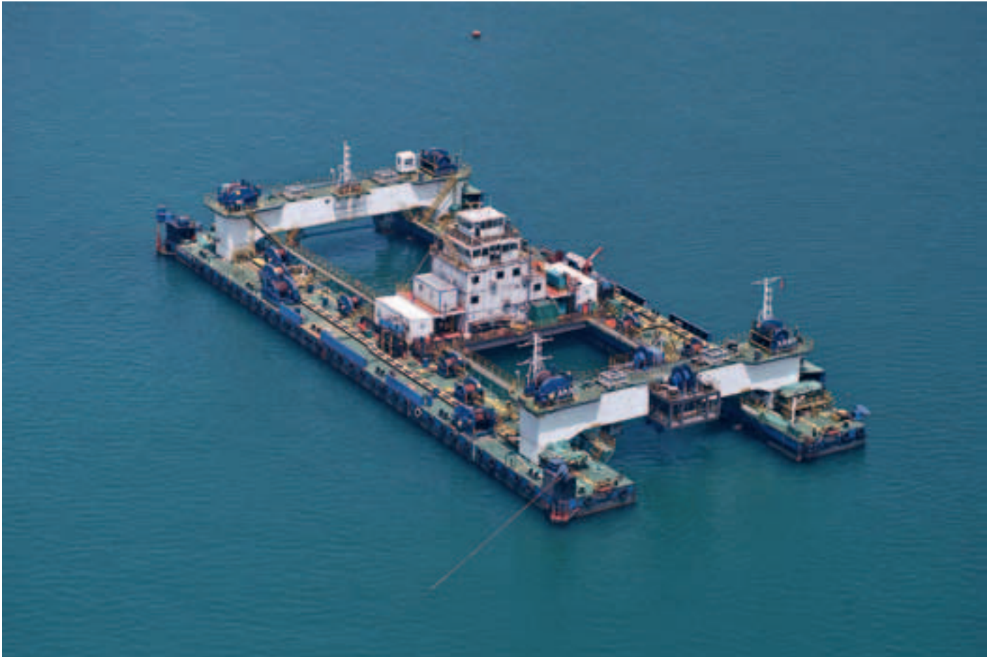
Abb. 6 (Bild oben) Ein Schwimmkran mit dem die Fertigteile abgelassen wurden in Position
