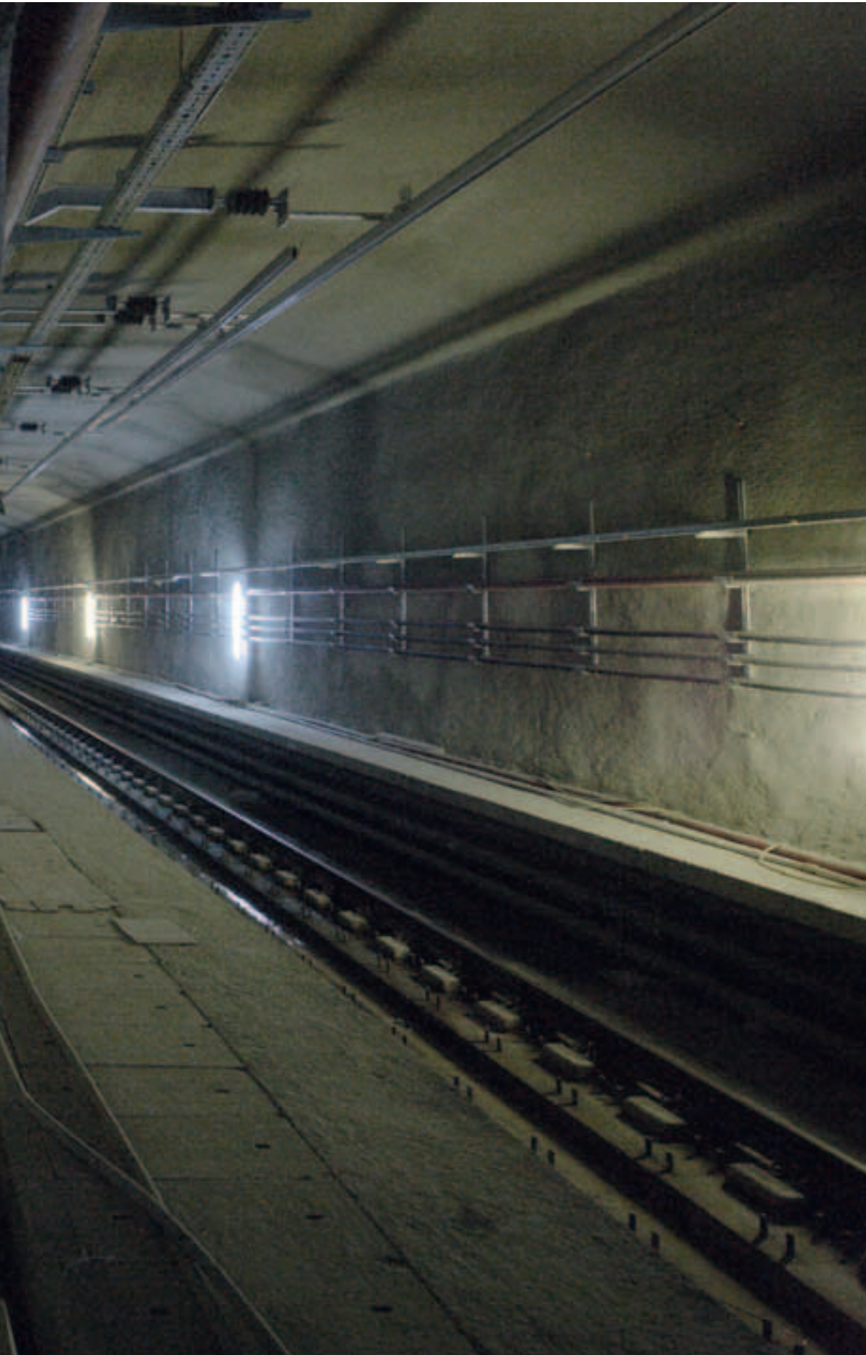
Abb. 3 (Bild links) In jedem Fertigteilsegment gibt es mehrere Verbindun- gen zwischen den beiden Röhrenhälften. Blick aus einer solchen auf beide zukünftigen Gleistrassen
