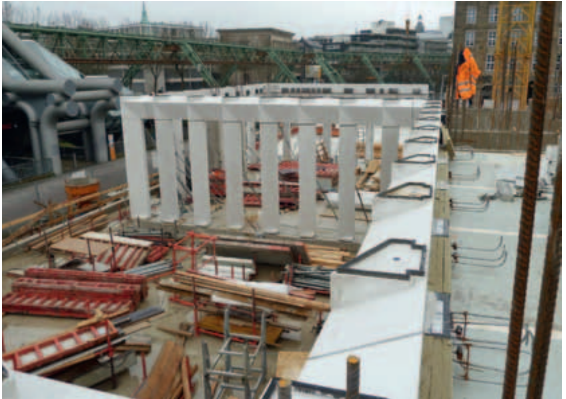
Abb. 6 (Bild oben) Bauzustand Decke über EG mit gestellten und ausgerich- teten Stützen des EG und des Kopfbalkens über dem EG
