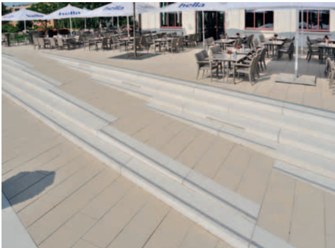
Abb. 5 (Bild oben) Winkelstufen, »Wasserwerk«
