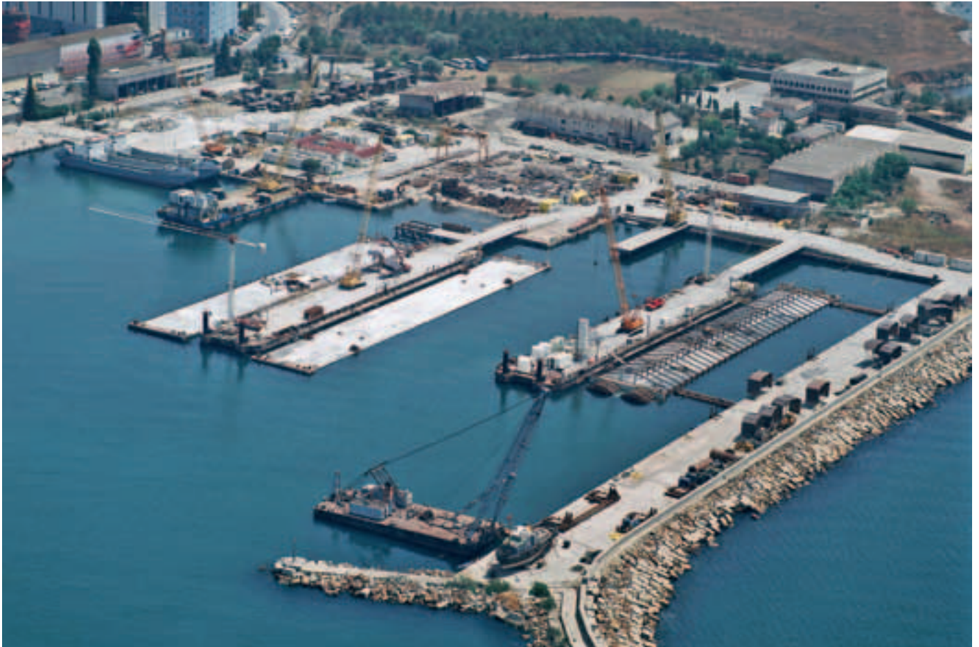
Abb. 5 (Bild oben) In den Wasserdocks erhielten die schwimmenden Fertigteile ihre Decken
