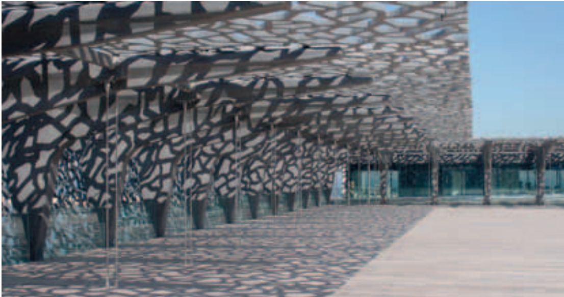
Abb. 5 (Bild links) Zwischen der Schatten spendenden Außenhaut und den tragenden Baumstützen des Kernbaus wurde eine halböffentliche Rampe angelegt
