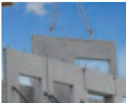
Betonfertigteilmontage
