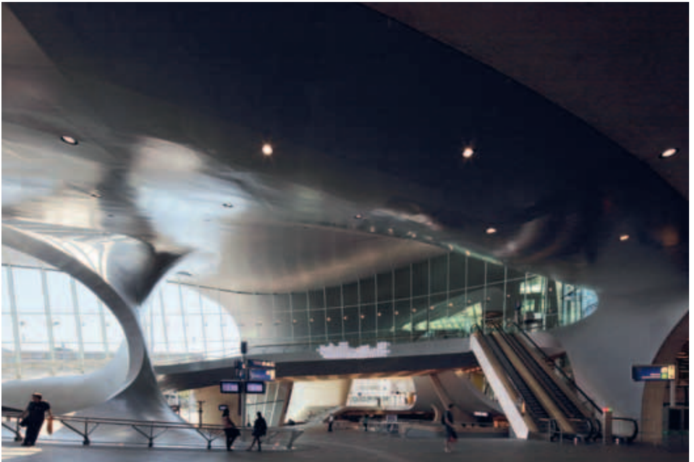
Abb. 5 (Bild links) Innenansicht der Empfangshalle. Links im Hintergrund der zentrale Twist, ein skulpturale Stahlkonstruktion, die jedoch keine statische Funktion besitzt
