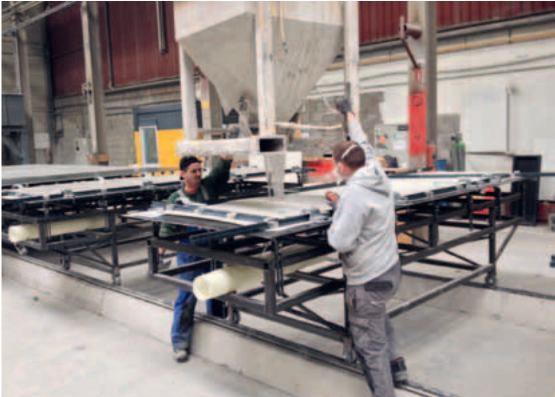
Abb. 10 (Bild oben) Die 40 mm starken Betonfertigteile wurden in einer ebenen Stahlschalung betoniert und erst während des Stockens nach Plan gekrümmt
