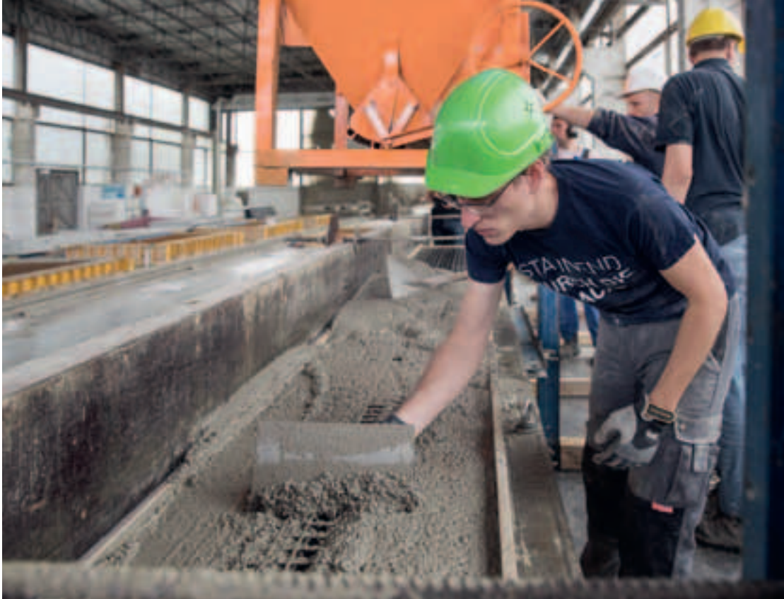
Abb. 2 (Bild links) Betonage eines Carbonbeton- trägers im Betonwerk Oschatz
