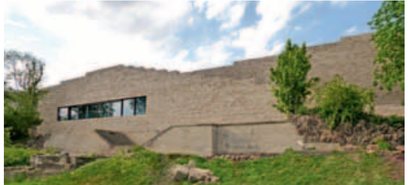
Die Dachterrasse der GRIMMWELT in Kassel wurde mit Peikko Auflagerkonsolen für TT-Plattendecken erstellt
