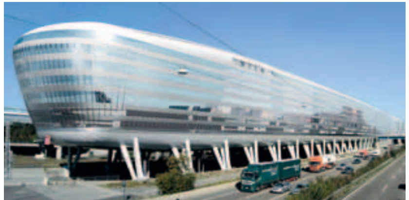
Im The Squire in Frankfurt am Main wurde die Konstruktionshöhe durch DELTABEAM Verbundträger maßgeblich reduziert
