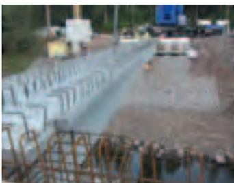
**BRÜCKEN** – aus Beton überzeugen durch ihre Dauerhaftigkeit und kostengünstige Ausführung. In unseren Fertigteilwerken können diese als vorgespannte oder schlaff bewehrte Einzelbrückenträger mit bauseitiger Ortbetonergänzung oder als schlaff bewehrter, vollmassiver Brückenoberbau, bei dem lediglich nach der Montage die Fugen ausgegossen werden müssen, ausgeführt werden.
