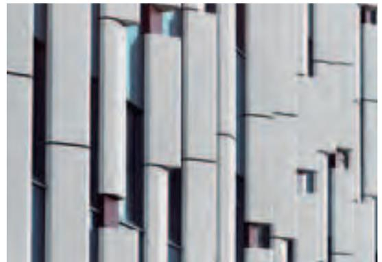
Life Sciences Building, Universität Vilnius. 5.800 m<sup>2</sup> fibreC Formteile mit 13 mm Stärke und bis zu 3 m Länge.
