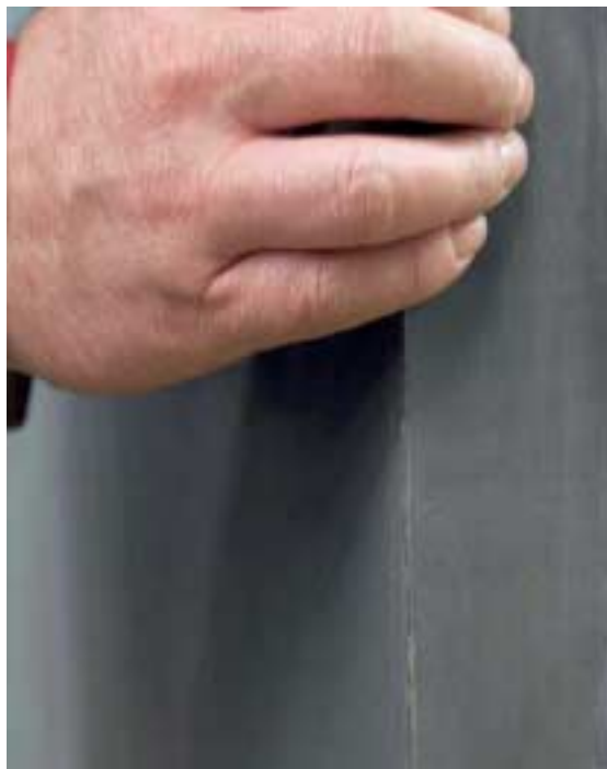
Fig. 1 Las características de los elementos prefabricados son los bordes afilados y las superficies lisas.
