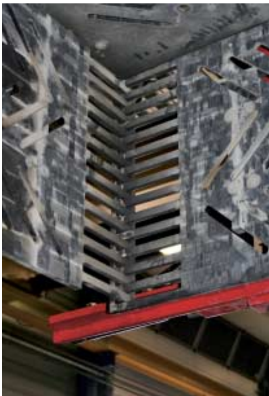
Fig. 6 La esquina de la jaula al detalle: las paredes están conectadas unas con otras por engranaje; las medidas de la jaula pueden ajustarse fácilmente.
