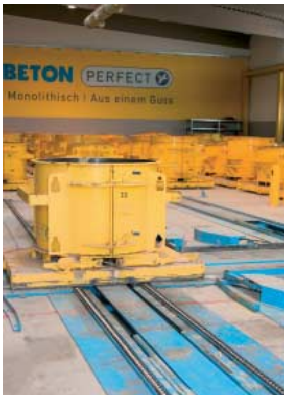
Fig. 8 Los moldes se desplazan con transportador de cadena desde el desmoldado al moldeado, y luego a la estación de hormigonado.
