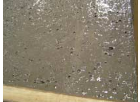
Fig. 23 Procesos de desaerización durante la vibración.
