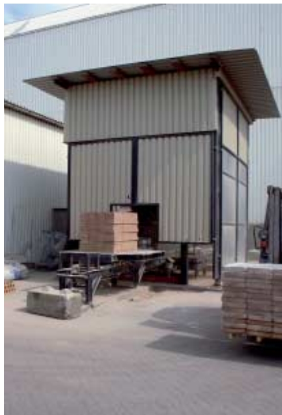
Fig. 7 En Excluton (antes Jonker Beton), en Ámsterdam, la máquina fue cubierta por una caseta.
