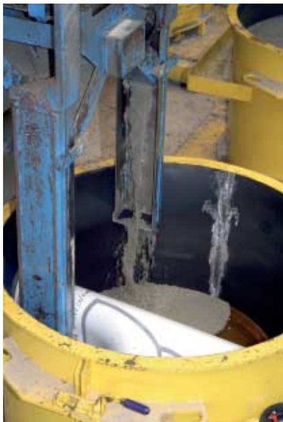
Fig. 10 Esparcidora de hormigón con dos salidas. La inserción de estas mangas previene que entre demasiado aire en el hormigón.
