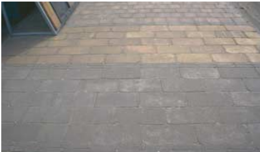
Fig. 9 Las diferencias entre los bloques pueden verse después de un año en el área de prueba.
