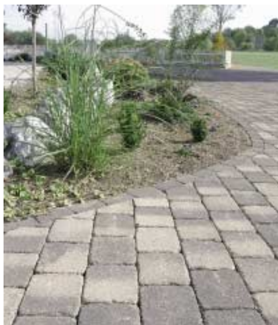
Fig. 2 Producto envejecido estándar instalado.
