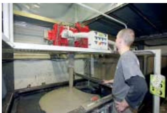
Fig. 1 Los pequeños contenedores se producen uno tras otro. Detrás (arriba) el tubo de trasvase dirige el suministro de hormigón al molde grande o al pequeño.
