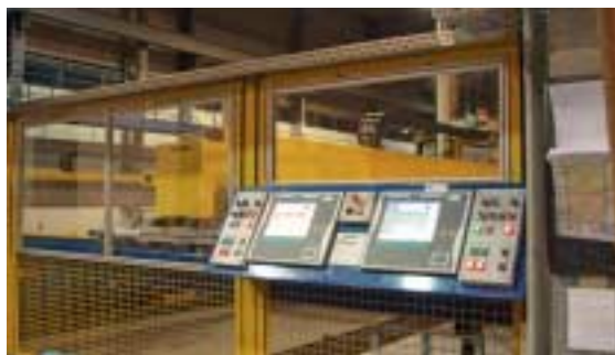
Fig. 13 Estación de control principal del robot de encofrado.
