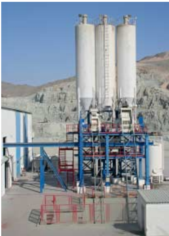
Fig. 2 Cada uno de los dos sistemas de circulación instalados tiene su propia torre de amasado. Hay disponibles tres silos para cada uno de los diferentes cementos.
