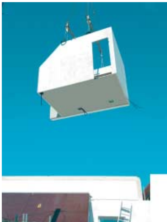
Fig. 2 La casa Icon es una sólida construcción consistente en varios módulos que aseguran tiempos de montaje in situ más cortos.
