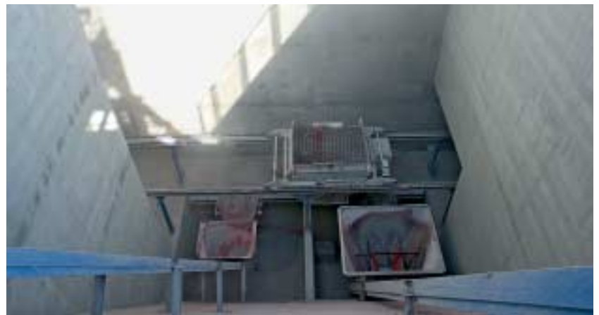
Fig. 3 Los áridos están almacenados bajo tierra; deben superar una diferencia de altura de unos 20 m para llegar a la plataforma de amasado.
