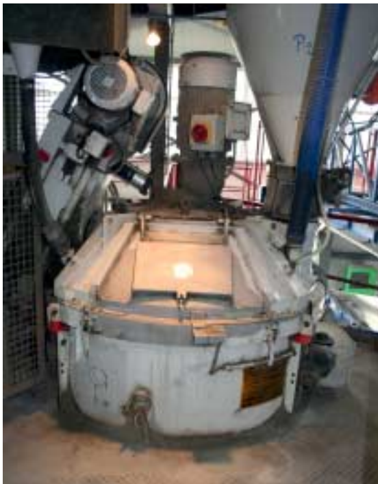
Fig. 3 Para el hormigón de cara vista, las dos amasadoras se han instalado en la plataforma. La mezcla producida «cae» en el dosificador de la mezcla de revestimiento de la prensa de losas.
