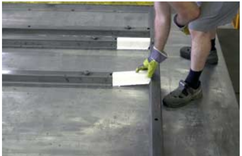
Fig. 6 Cierre de encofrado de poliestireno, que pronto podría hacerse automáticamente.
