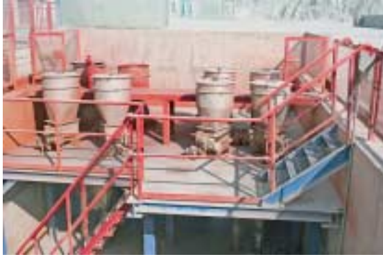
Fig. 4 Los pigmentos para la coloración de hormigón se dosifican en la plataforma de amasado.
