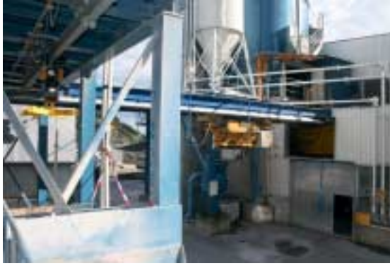
Fig. 2 El hormigón granulado se produce usando una amasadora en una de las instalaciones vecinas y se transporta a la producción de baldosas por medio de un mecanismo de cangilones.
