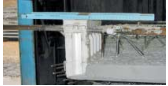
Fig. 19 Comparación de las dimensiones de las conexiones de losas voladizas con aislamiento térmico.
