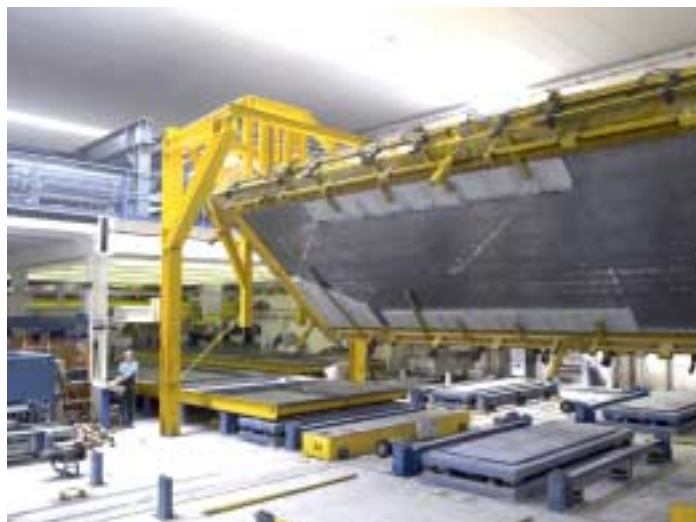
Fig. 11 Desde el punto de vista de la seguridad, el giro de paredes dobles siempre será un área problemática.
