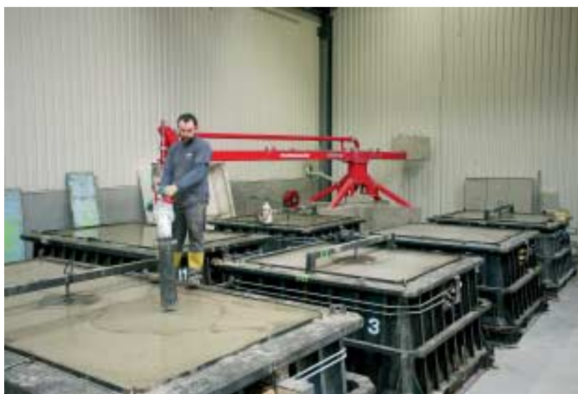
Fig. 2 Hormigonado de los moldes para grandes contenedores con un distribuidor mecánico que gira manualmente.
