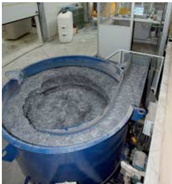
Fig. 4 Las fibras de acero se añaden proporcionalmente a cada partida de hormigón.
