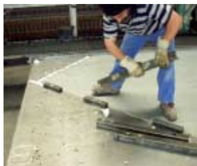
Fig. 5 Alejamiento de los magnetos (izquierda) y ordenación linear de enrejado sobre superficie de encofrado acero.
