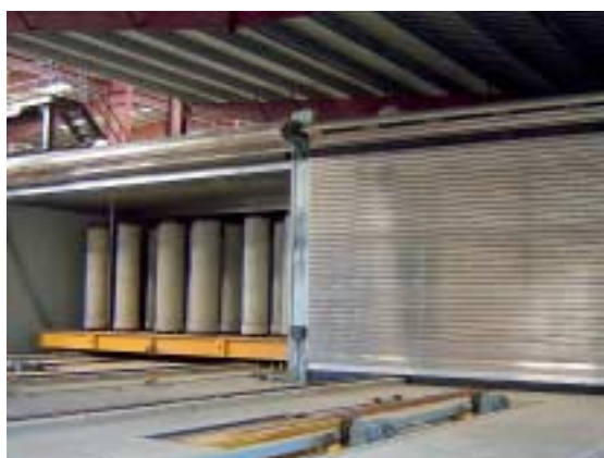
Fig. 6 El sistema de curado cuenta con un sistema de calefacción de la empresa Kraft Energy Systems, Inc.
