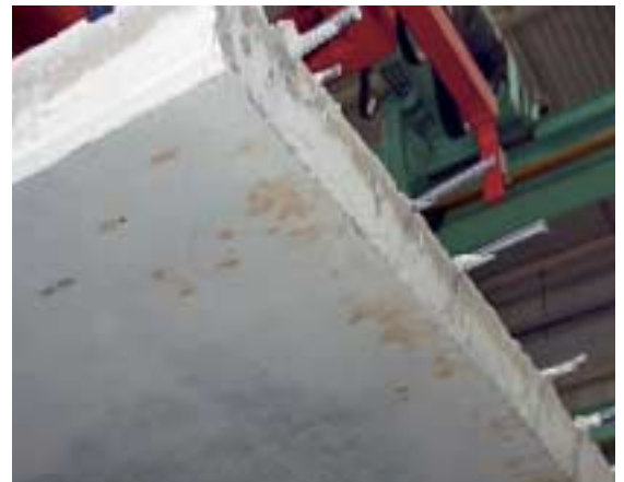
Fig. 1 Atrás de levantamiento de elemento prefabricado, manchas de enrejado se tornan visible (a lado izquierdo) que se forman, negativamente, al superficie del elemento (a lado derecho).
