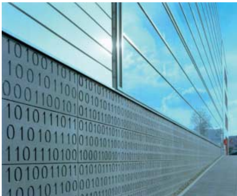
Fig. 7 El hormigón de estos elementos betoShell se coloreó de antracite, y la superficie se chorreó con arena. El código binario estampado en segundo término se realizó con hormigón visto a petición del despacho de arquitectos « Bahl und Partner » de Hagen, Alemania.
