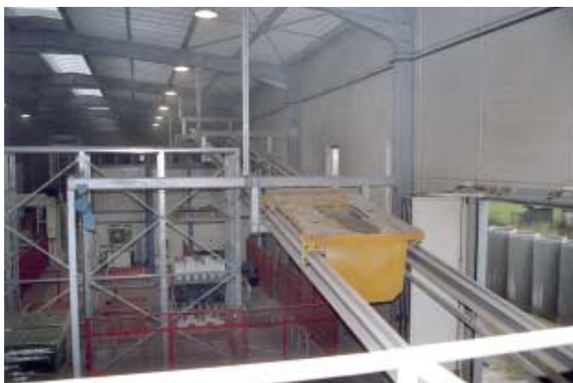
Fig. 3 Transporte do betão fresco para a máquina de fazer blocos.
