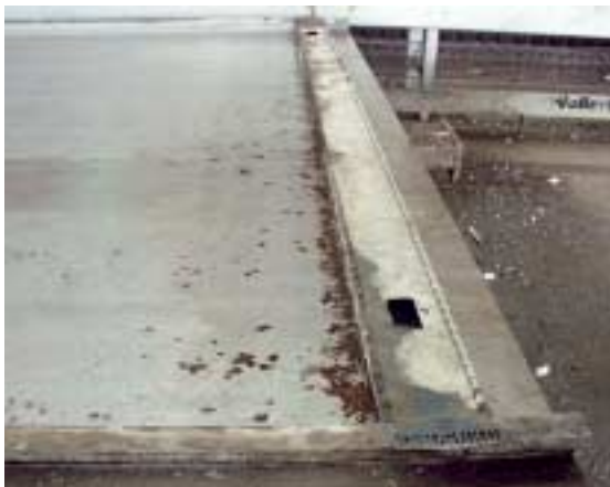
Fig. 1 Atrás de levantamiento de elemento prefabricado, manchas de enrejado se tornan visible (a lado izquierdo) que se forman, negativamente, al superficie del elemento (a lado derecho).
