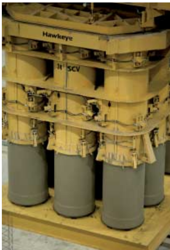
Fig. 5 El molde se eleva, y las tuberías – apoyadas en el manguito – se dejan en el vagón plataforma.
