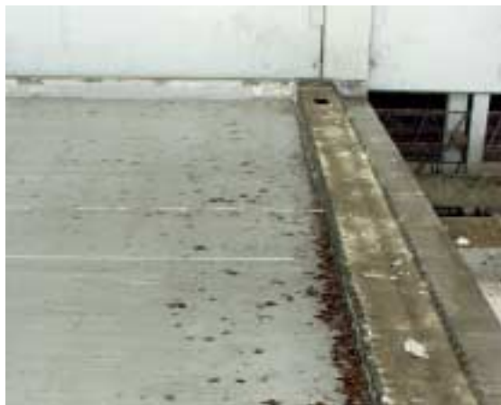
Fig. 3 Formación típica de enrejado a los fines de encofrado y las manchas de enrejado han transferido a la cara de hormigón.
