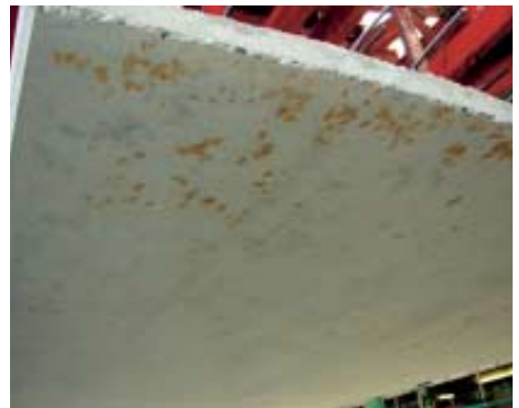
Fig. 3 Formación típica de enrejado a los fines de encofrado y las manchas de enrejado han transferido a la cara de hormigón.
