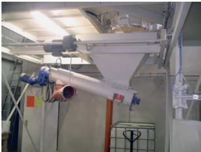
Fig. 3 Silo móvil situado aguas abajo.
