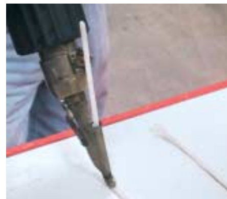
Fig. 3 Las reparaciones se ejecutan con un soldador de mano y una fresa de pinturas.
