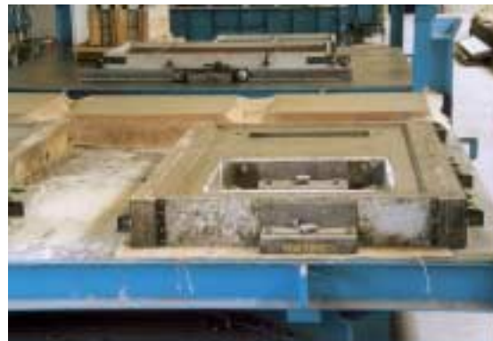
Fig. 7 Encofrado tras el hormigonado y emparejado del hormigón.
