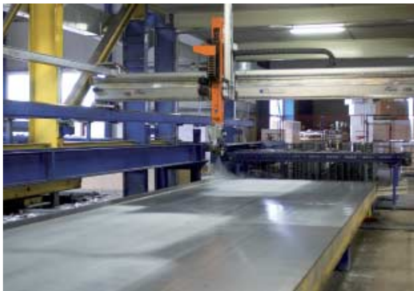
Fig. 2 El robot al aceitar la superficie de encofrado ocupada.
