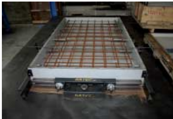
Fig. 6 Encofrado cerrado y armado con placas alkus para elementos de senderos.
