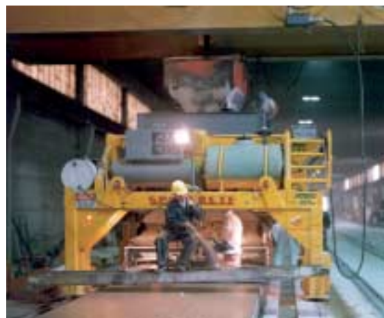
Fig. 6 Hormigonado de la envoltura exterior.
