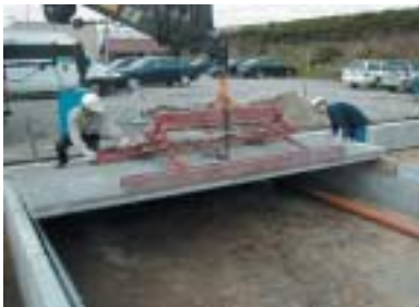
Instalación de los elementos Drain-Deck Instalação dos elementos Drain-Deck
