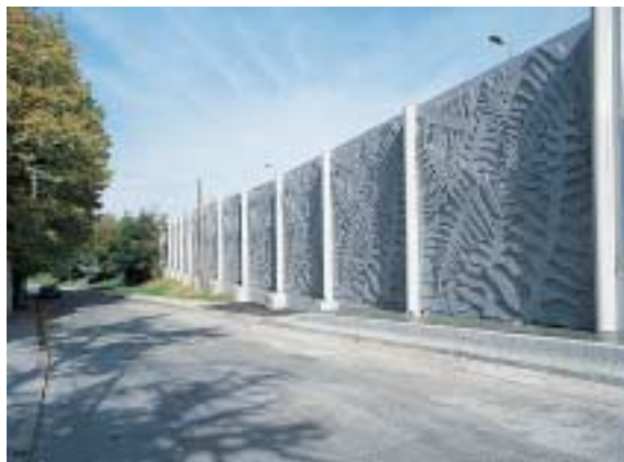
Figura 1. St. Etienne, Francia: Muro de protección acústica, absorbente, molde especial
