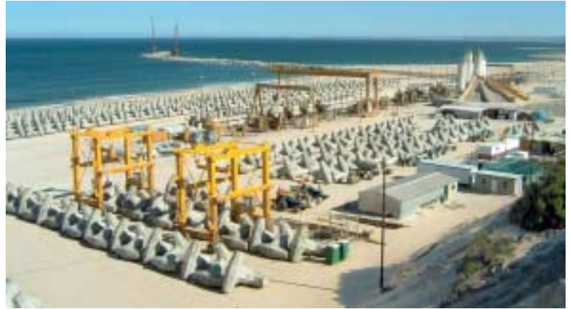
Fig. 5: En primer plano puede observarse las grúas especiales de transporte de 10 m de altura. Al fondo se observa los primeros cientos de metros del rompeolas Figura 5: Em primeiro plano os guindastes de transporte especialmente projetados com 10 m de altura. No fundo os primeiros metros da barragem quebra mar
