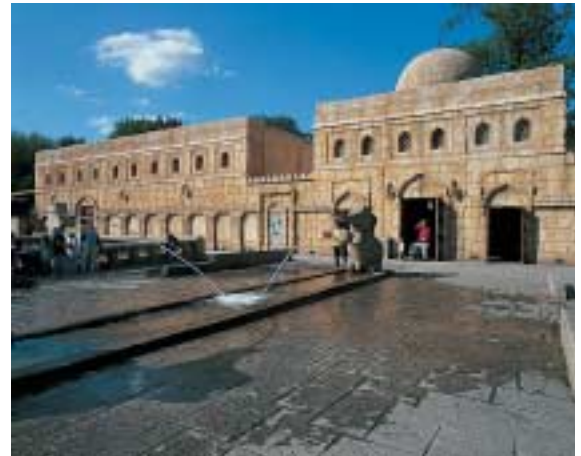
Figura 4. Zoo en Hannover: Recinto de elefantes, hormigón in-situ y elementos prefabricados, moldes especiales Figura 4. Hannover: Casa dos elefantes no Zoo, betão moldado no local e elementos pré-fabricados, molde especial
