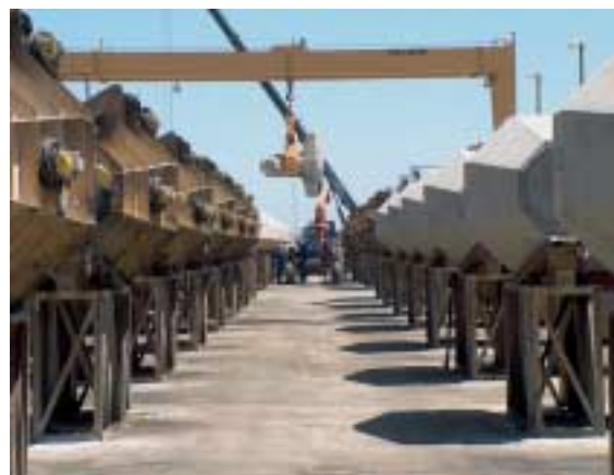
Fig. 3: El molde para cada dolo cuenta con un total de 9 vibradores externos
