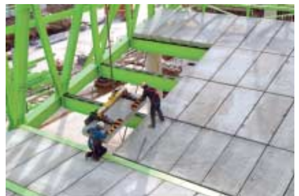
Figs. 3, 3a. Las placas, fabricadas con el prototipo se emplean en un cine en Almere, Países Bajos Figs. 3, 3a. Lajes ocas construídas com o protótipo foram usadas para a construção de um cinema em Almere, Holanda
