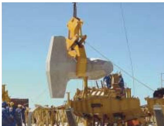
Fig. 2: Los dolos se retiran del molde tras 18 horas de fraguado
