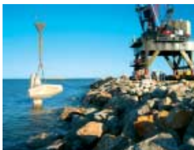
Fig. 7: Instalación del primer dolo del rompeolas de Ngqura Figura 7: Instalação do primeiro dolos para a barragem quebra mar Ngqura
