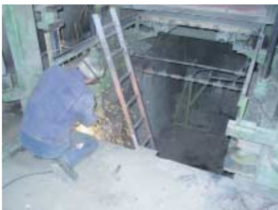
Fig. 3. Remoção dos componentes de sustentação da mesa vibradora velha
