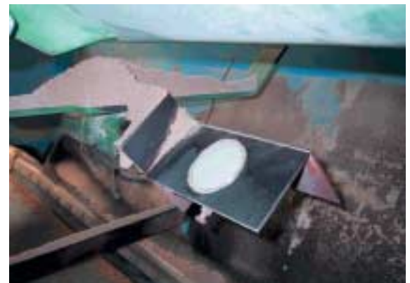
Fig. 5. Instalación estándar del sensor para la medición de la humedad de los áridos
