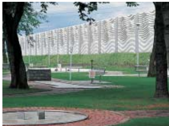
Figura 2. Hamm: Muro de protección acústica, A2, molde especial
