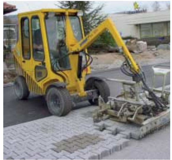
VM 203: aplicable en múltiples funciones – disposición de piezas de bordillo, placas, enarenado, transporte, enlodado, barrido, etc.
