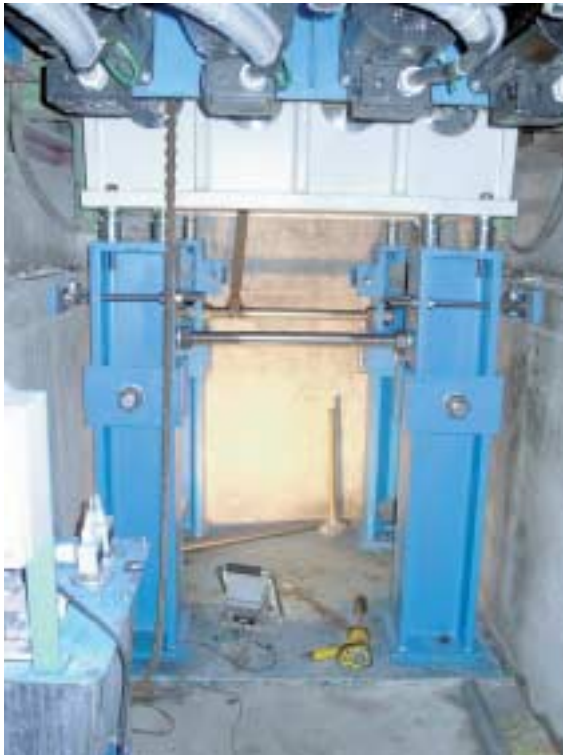
Fig. 4. Marco constructivo independiente para la nueva mesa de vibrado Fig. 4. Subconstrução separada para a nova mesa vibradora
