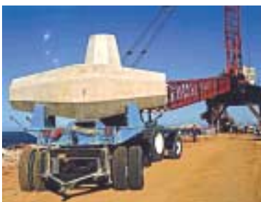
Fig. 6: El transporte de los elementos se realiza mediante remolques especialmente diseñados arrastrados por tractores
