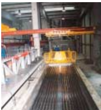
Fig. 9. Aprovisionamiento del pallet con nuevos cables tensores Fig. 9. Montagem dos arames de tensão
