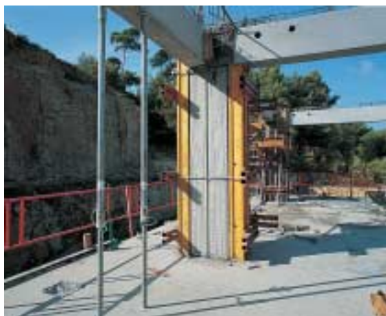
Figura 8. La Ciotat, Francia: Pilares en el edificio de producción de una fábrica de ordenadores
