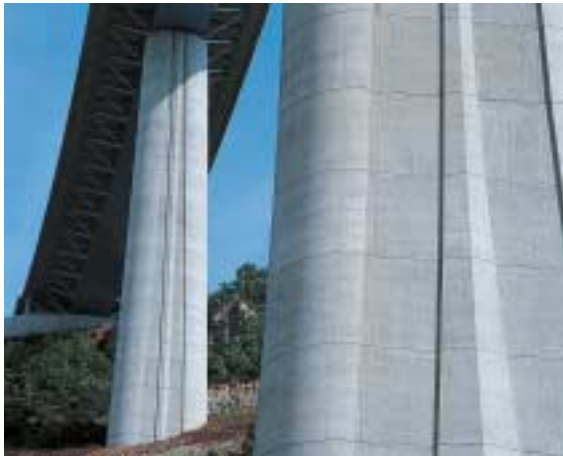
Figura 3. Verière, Francia: Puente sobre la autopista A71, estructura 2/69, Marne
