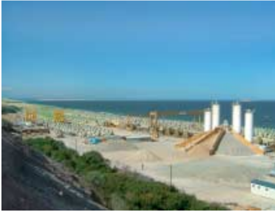
Fig. 4: La nave de almacenamiento temporal tiene capacidad para 2000 elementos prefabricados Figura 4: O depósito temporário do produto acabado tem uma capacidade de armazenamento para 2000 dolos
