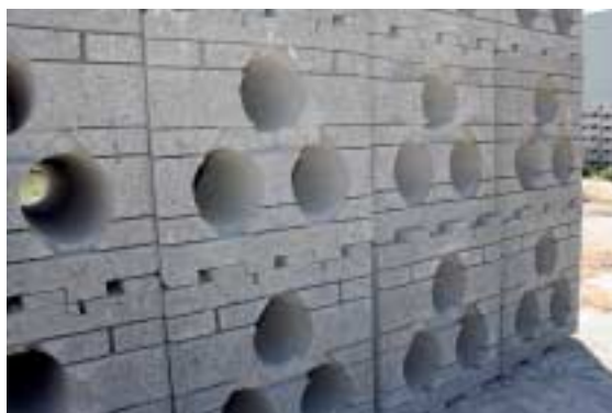
Fig. 1 El Geobloc: un gran bloque usado para diseñar y levantar muros reforzados.
