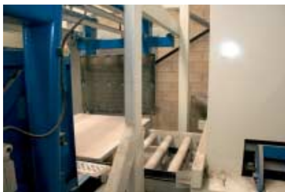
Fig. 7 La planta de empaquetado: se empuja el paquete de bloques completo (como se muestra en la imagen trasera) desde el palet de producción. El palet vacío se transporta por la cinta de rodillos al almacén de palets (derecha). El cubo de bloques se envía en el transportador de placa de acero al flejado automático.
