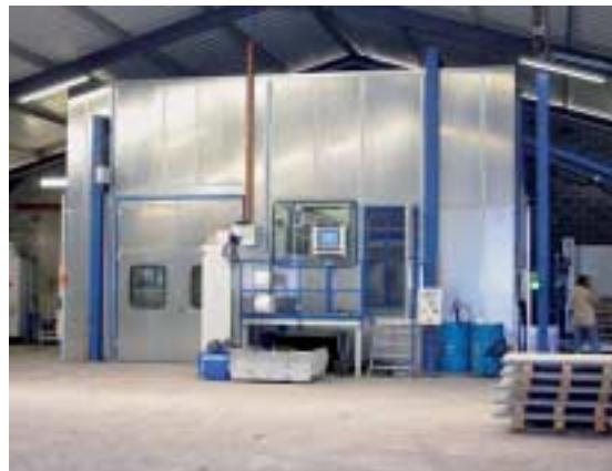
Fig. 3 Zenith 844 encapsulada en NV Windmolders Beton.
