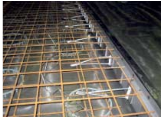
Fig. 5 Diseño de la ranura moldeada con conexión de alambre.
