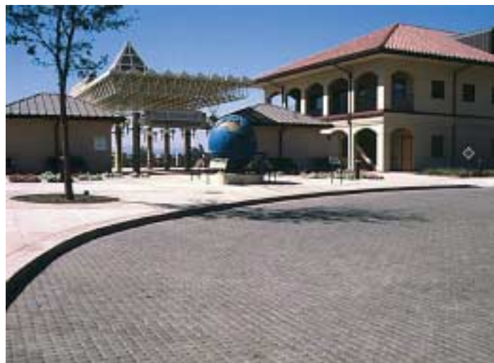
Fig. 3 Depuradora Rio Vista, Santa Clarita, California, equipada con pavimento permeable al agua Uni Eco Stone 80 mm.
