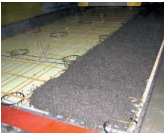
Fig. 6 A la colocación de la armadura para el hormigón de paramento le sigue el hormigonado de la superficie de hormigón visto con el hormigón de paramento y la siguiente compactación mediante técnica vibratoria de bajo ruido.
