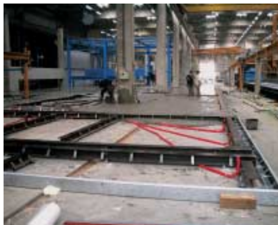
Fig. 2 Fijación y montaje de piezas incorporadas sobre el suelo existente, hormigonado de un nuevo suelo.
