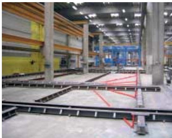
Fig. 2 Fijación y montaje de piezas incorporadas sobre el suelo existente, hormigonado de un nuevo suelo.
