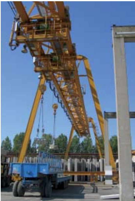
Fig. 9 Pieza de hormigón terminada lavada se almacena con referencia a su pedido en el lugar de almacenaje o directamente sobre los semi-remolques.
