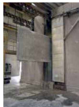
Fig. 8 Lavado de la superficie de hormigón de paramento en la instalación de lavado.
