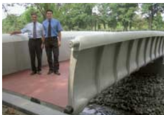
Fig. 4 El Director-Gerente de Betonwerk Oschatz, Señor Dietmar Schurig y su hijo Matthias Schurig como los primeros peatones sobre el puente de hormigón textil.
