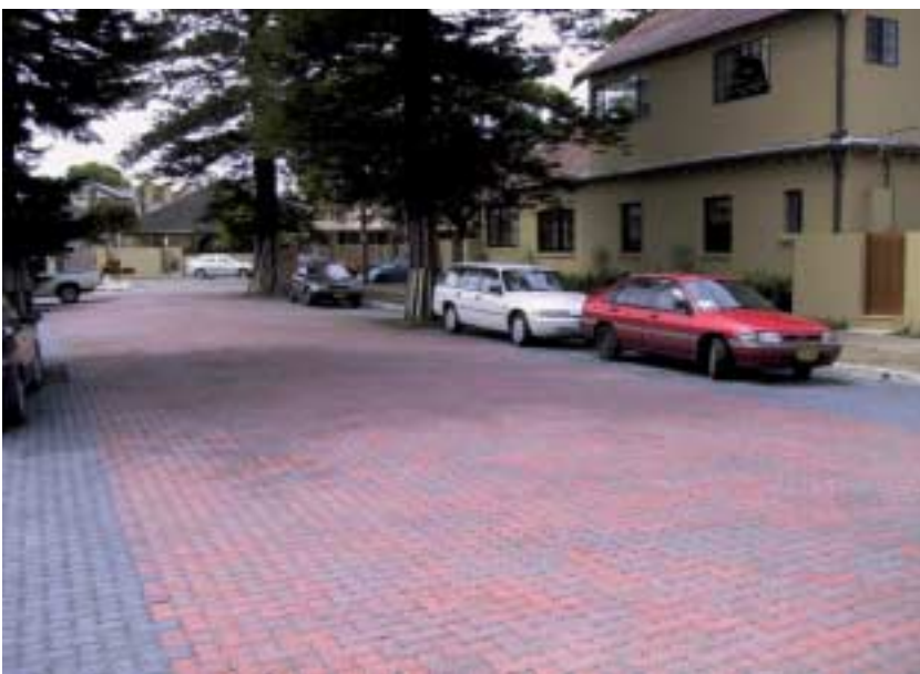
Fig. 1 Smith Street, Manly, Sydney. Calle de acceso a viviendas alrededor de 1900, reequipada con pavimento con capacidad de infiltración Uni Ecoloc 80 mm [15].
