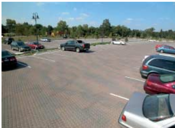
Fig. 2 Morton Arboretum, Chicago, aparcamiento de aprox. 20.000 m 2 con junta verde, equipado con pavimento permeable Uni Ecoloc [16].
