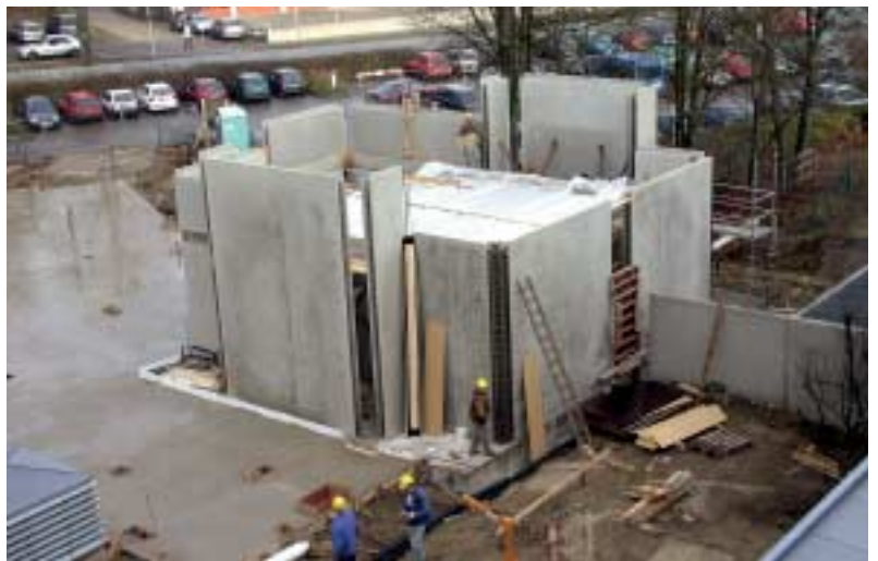
Fig. 1 y 2. La instalación de terapia de alta energía en Mühldorf am Inn: la primera estructura de apantallado contra la radiación en construcción sándwich del mundo. Fig. superior: muestra los paneles de doble pared de la carcasa interior durante su montaje. Fig. inferior: muestra los paneles de doble pared de la carcasa exterior. Para los diafragmas de cubierta en voladizo se han previsto ranuras continuas en la carcasa exterior
