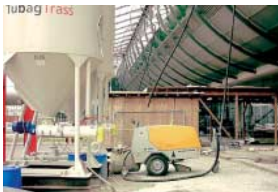
Figura 3. Silo con Wetmix en la obra en el aeropuerto de Leipzig
