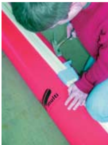
Cuñas de fijación situadas aproximadamente cada 35 cm Colocação dos esticadores à distância de 35 cm aprox.
