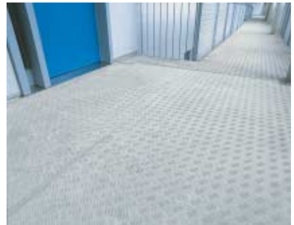
Piedra artificial con estructura en lámina corrugada Bloco de betão em estrutura de chapa estriada
