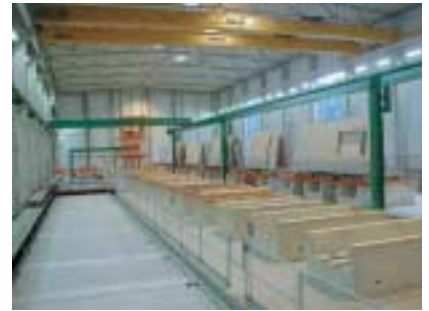
Fig. 5. Zona de desmoldeo de unidades de cubiertas y muros en Skandinaviska Byggelement AB, S-Katrineholm
