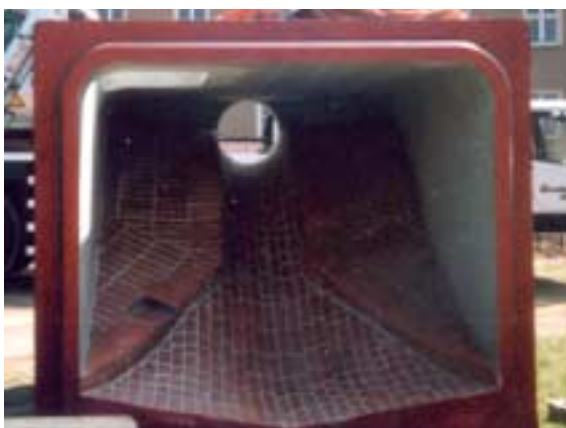
Fig. 14. Instalación de fabricación Nordhausen/Bleicherode de 2,25 m x 2,0 m. Estructura de alimentación integrada con terminación hidráulica con aspecto superficial de clincker, diferencia de nivel entre la estructura de entrada y la de salida aprox. 1,40 m. L = 60 m
