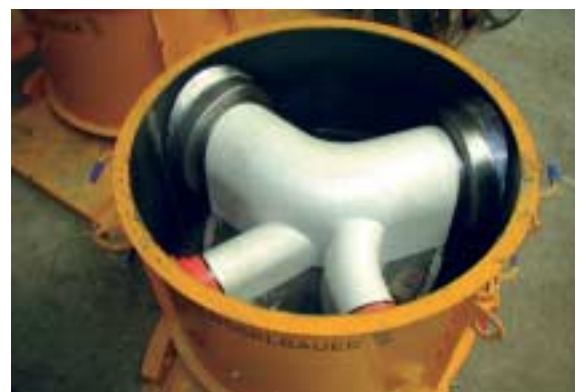
Fig. 3. Equipamiento completo de molde previo al hormigonado Fig. 3. Equipamento de molde completo antes da betonagem
