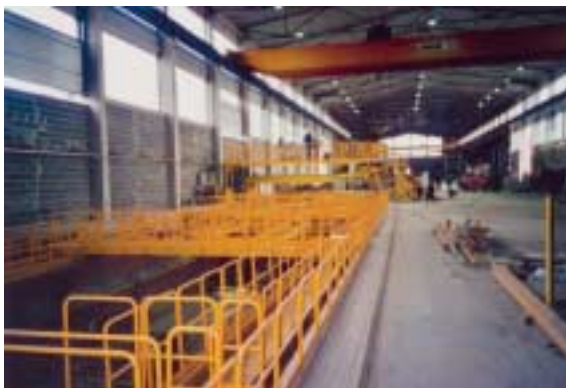
Fig. 10. Instalación de fabricación 60 x 10 m para elementos de sección transversal rectangular y tuberías de grandes dimensiones. Equipo de elevación para 50 a 90 toneladas
