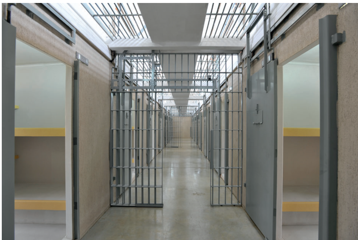
1 Внутренний вид помещений тюрьмы выполненных из предварительно изготовленных элементов в Бразилии
