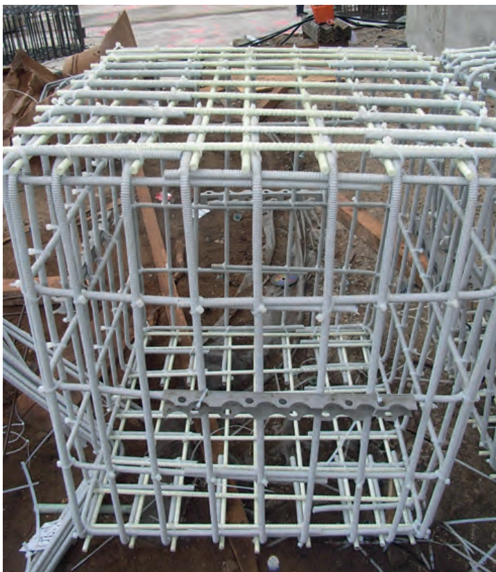
Фундамент выпрямителя в компании Peine Träger GmbH: арматура ComBAR из стекловолокна
