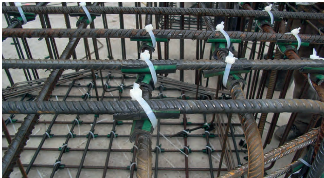
Изоляция арматуры фундамента с использованием резиновых шлангов
