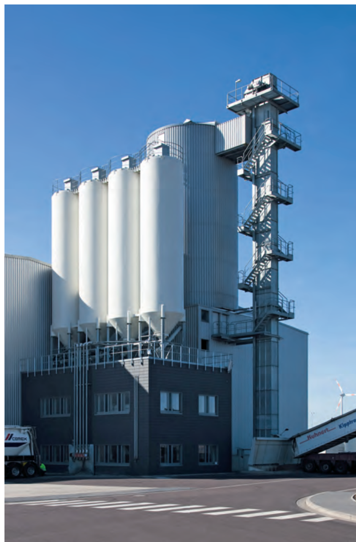
Бетоносмесительная установка башенного типа Betomat III-570 с тарельчатым смесителем RIM 3.0-D
