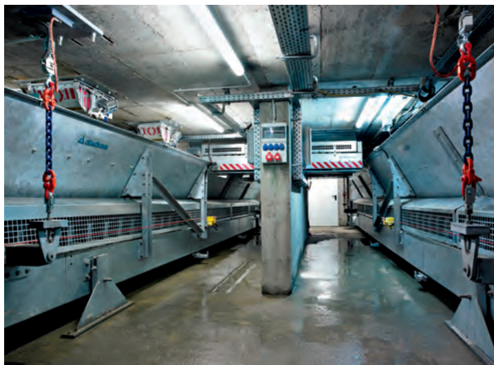
4 Заполнители из силосов транспортируются с использованием взвешивающих лент.
