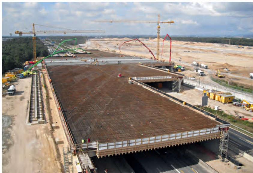
Бетонирование площадки на мостовом сооружении
