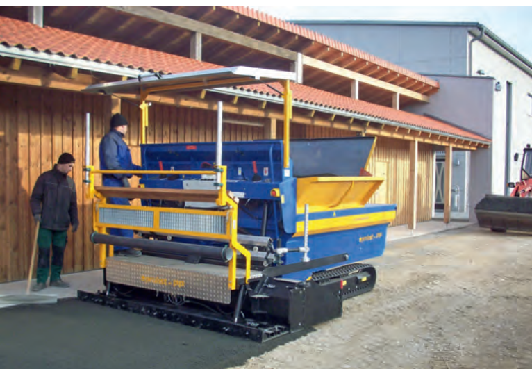
Укладчик верхнего слоя Power Plan PP в работе при сооружении покрытия площадки для отдыха автомобилистов на автобане
