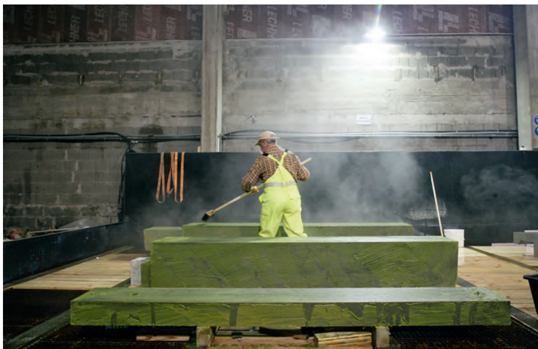
Обработка кислотосодержащим микрогелем компании Nebau сборной железобетонной конструкции. В зависимости от цвета бетона плёнка приобретает ярко зеленый оттенок
