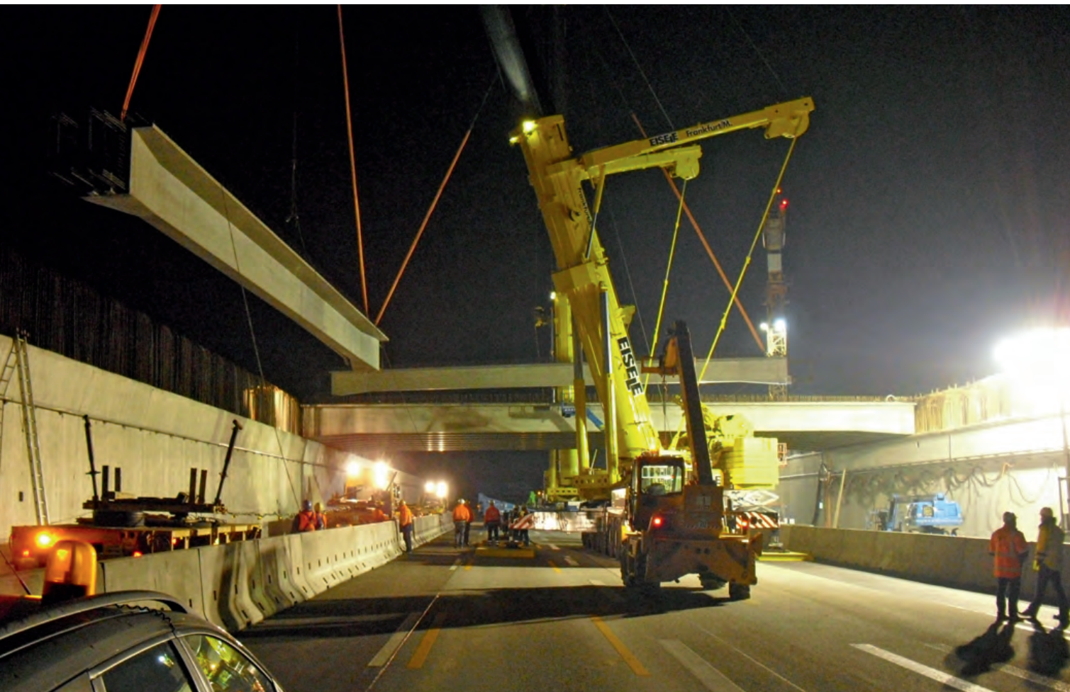
Монтаж бетонной балки для мостовых сооружений
