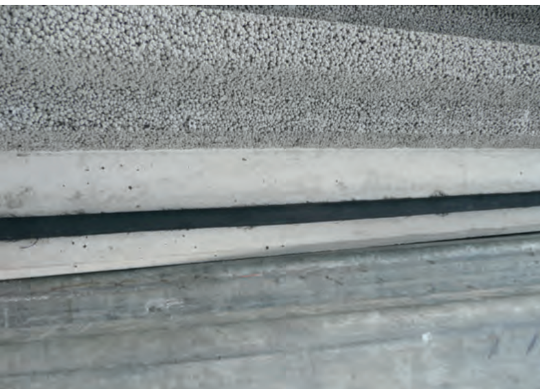
Герметизирующая лента RubberElast® водо- и газонепроницаемо соединяет бетонные конструкции
