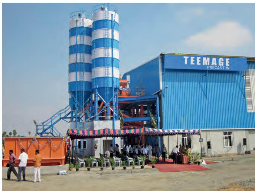
Смесительный узел, состоящий из двух смесителей объёмом по 1,5 м 3 .
