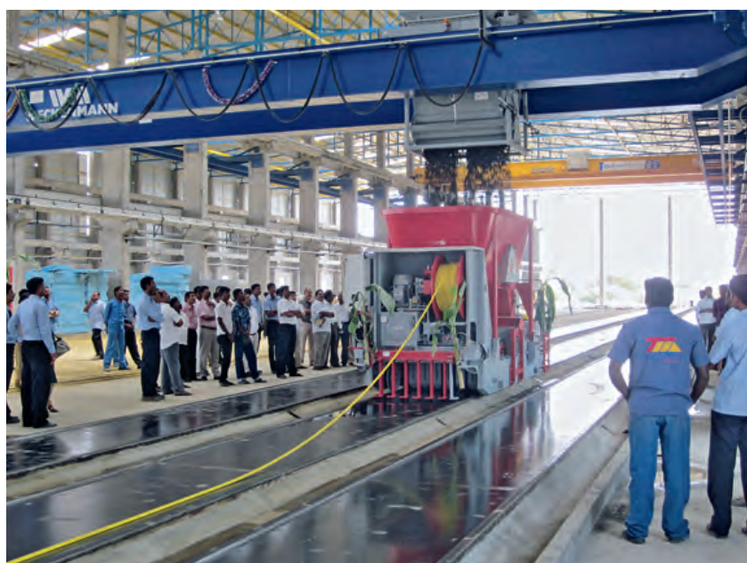
С использованием подвижной опалубки в настоящее время можно ежедневно производить 450 м 2 пустотных плит перекрытия.
