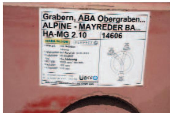
**Рис. 3** Наклейка с детальной информацией об изделии сопровождает кольцо с дном от начала производственного процесса до монтажа на строительной площадке.
