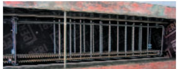
**Рис. 9** Высокоэффективное комбинированное поперечное армирование, работающее на изгиб и растяжение.
