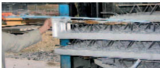
**Рис. 17** Обычные консольные соединительные элементы в сборных плитах.
