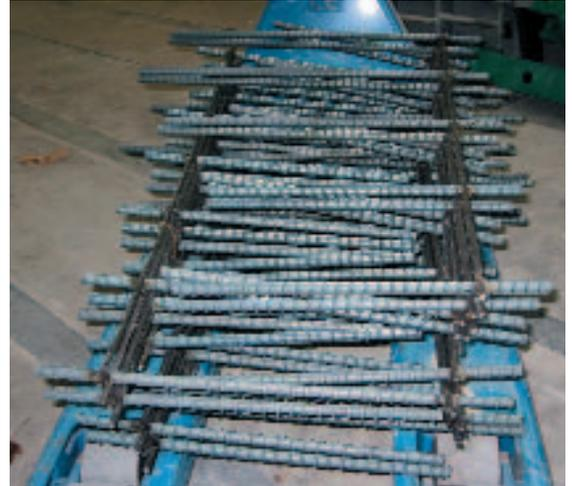
**Рис. 8** Высокоэффективное комбинированное поперечное армирование в форме гребня для балок или плит.
