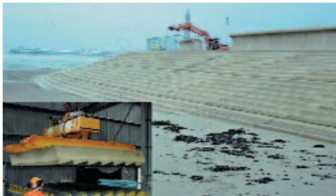
Рис. 6 Возведение фибробетонного укрепления набережной в г. Блэкпул (Великобритания).
