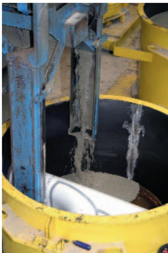
**Рис. 10** Бетоноукладчик с двумя желобами. Погружение в опалубку желобов препятствует попаданию излишнего воздуха в бетон.
