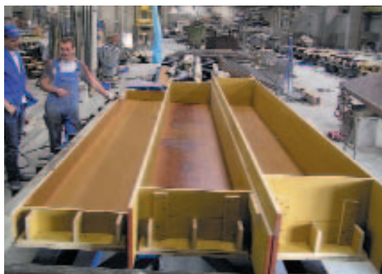
Рис. 21 Подготовка к испытаниям с использованием разноразмерных форм.
