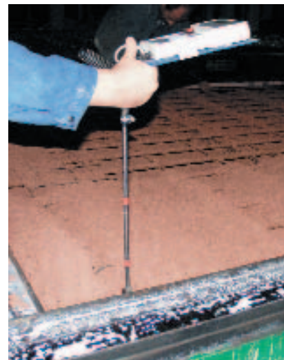
Рис. 4 Измерение перепадов динамического давления в свежем бетоне во время уплотнения.
