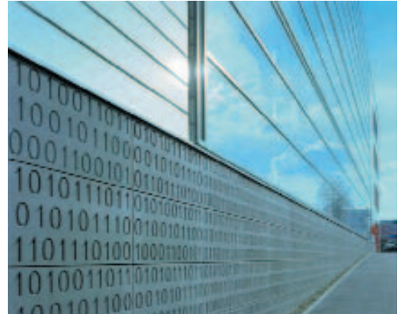
Рис. 7 Бетон этих изделий betoShell был расцвечен антрацитом, поверхность отшлифована. Тисненный двоичный код был выполнен на неоштукатуренном гладком бетоне по заказу архитектурной компании Bahl und Partner из Хагена.
