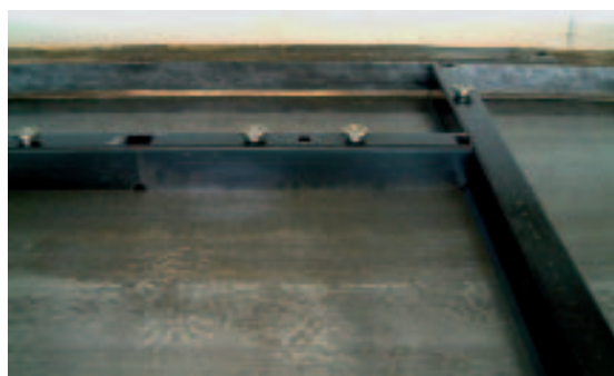
Рис.8 Применение опалубки с интегрированными магнитами: идеальное, беззазорное позиционирование при формировании Т-образного стыка (а) и при продольной стыковке (б).
