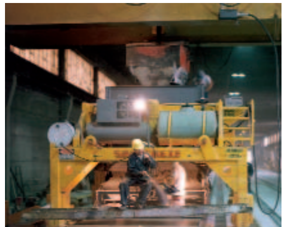
Рис. 6 Бетонирование внешнего отделочного слоя.
