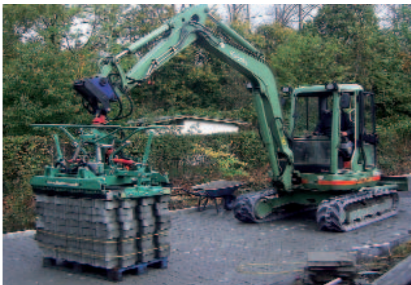
Рис.9 Как и в случае с машиной-укладчиком, захват Hunklinger Type 03, установленный на одноковшовом экскаваторе, укладывает блоки в ложковый ряд. Качательное движение стрелы экскаватора позволяет отказаться от перемещения машины.
