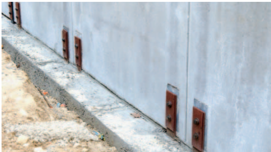
Рис. 10 Новый соединительный узел для панели сейсмостойкой стены.
