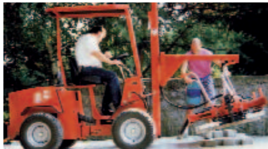
Рис.4 Адаптируемая стрела-манипулятор машины Uni-Truck производства Grunig упрощает процесс укладки слоя плитки на наклонную поверхность за счет того, что наклонные цилиндры также устанавливаются под углом.
