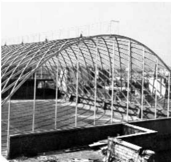
Рис. 1 Стальная ламельная конструкция, теннисный зал в Париже.
