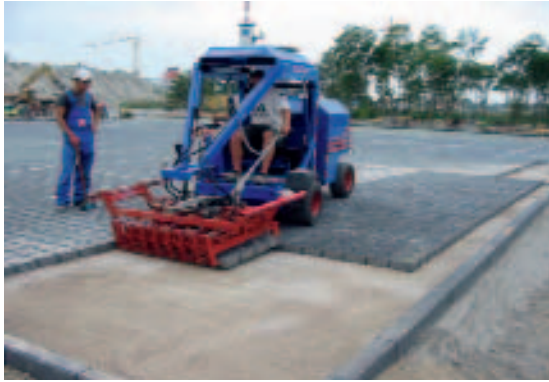
Рис.5 Правой рукой оператор управляет машиной, а левой — укладывает плитку. Конструкция Hydromak Vario 2000 позволяет не только свободно управляться с машиной в одиночку, но и дает неограниченный обзор края рабочей зоны.
