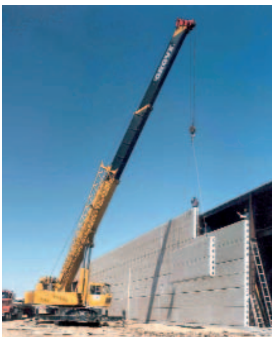
Рис. 2 Горизонтальная стеновая панель, перекрывающая пролет.
