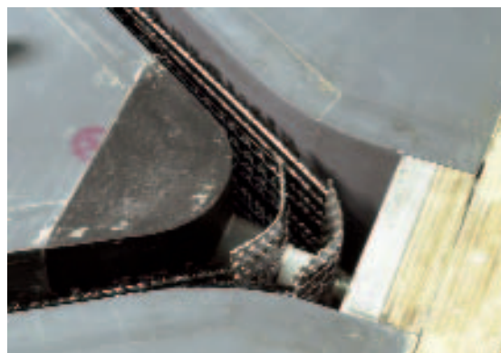
Рис. 11 Армирующий канал в перфорированных пластинах на пересечении.
