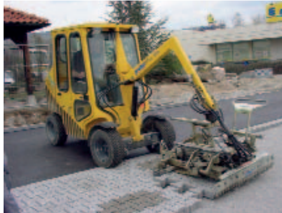
Рис.3 Наличие программируемого контроллера PLC на VM 204 Robotec производства Probst с джойстиком упрощает последовательность перемещений, так как перемещения захвата заранее программируются и выполняются автоматически.
