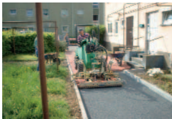
Рис.10 Малогабаритные погрузчики типа машины Avant с шарнирным управлением, представленной здесь с захватом производства Probst, за счет высокой маневренности в работе оказываются проворнее экскаваторов с захватом для укладки плитки.
