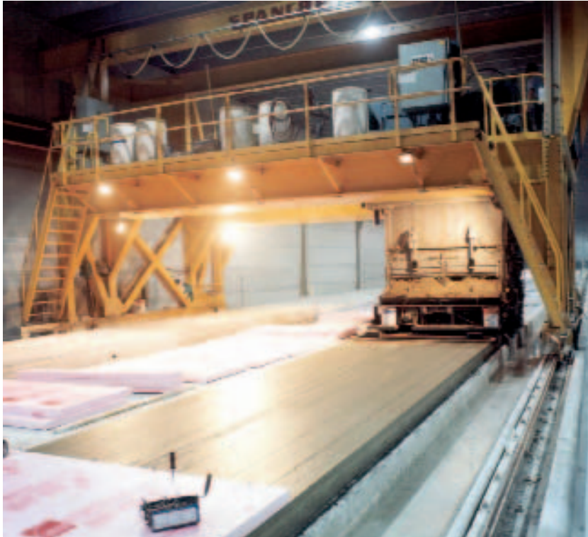
Рис. 4 Изготовление плиты с полым сердечником.
