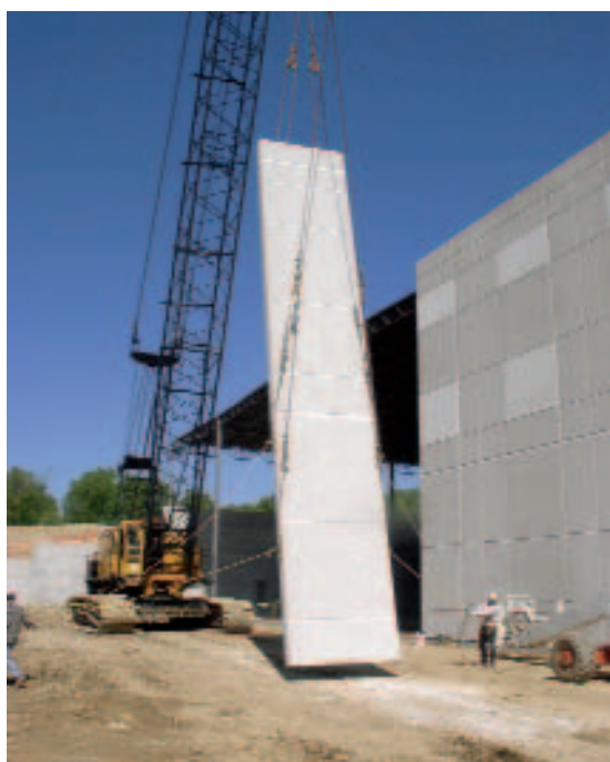
Рис. 3 Стеновая панель, установленная вертикально.
