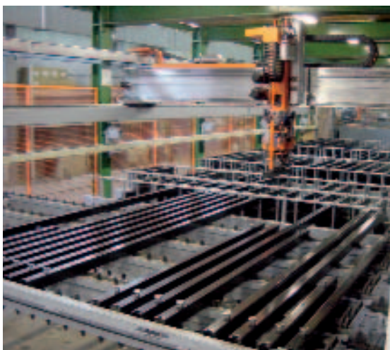
Рис. 1 Магазин опалубки на заводе Losch. Демонстрация работы робота при выполнении операций захвата опалубки из пассивного магазина, активный магазин показан на переднем плане.
