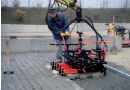
Рис.8 Гидравлические захваты производства Optimas для навески на транспортеры могут поставляться как для одно— так и для двухконтурных гидравлических систем. Имеется возможность настройки под блоки разной формы, площади и толщины.
