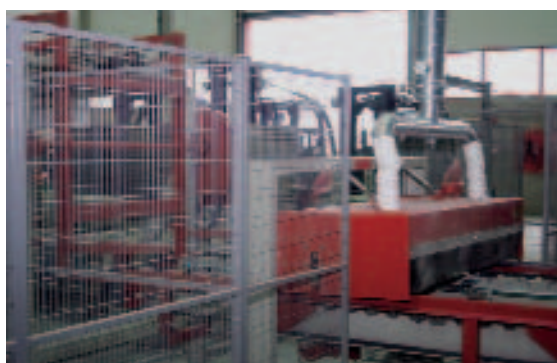
Рис. 7 Система отвода пыли установлена перед опрокидывателем щитов.
