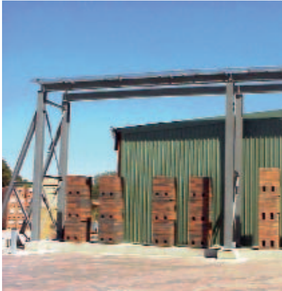
Рис. 16 Готовые пакеты блоков помещены на склад промежуточного хранения.
