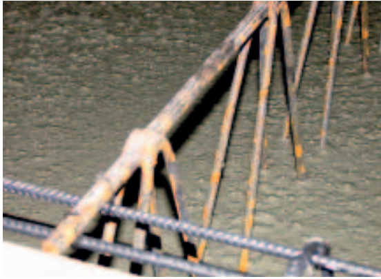
Рис. 2 Уплотненный свежий бетон нижнего уровня.
