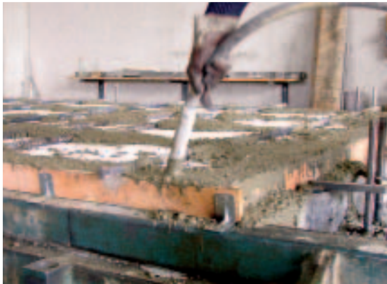
Рис. 4 Уплотнение легкоуплотняемого бетона между элементами из бетона ААС.
