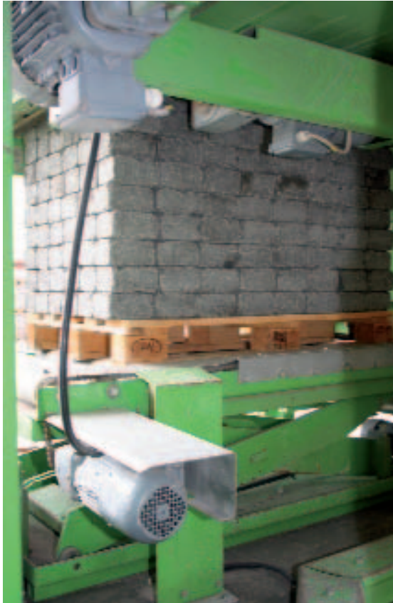
Рис. 6 После укладки одного слоя поддон на ножничном столе опускается на высоту одного слоя брусчатки.
