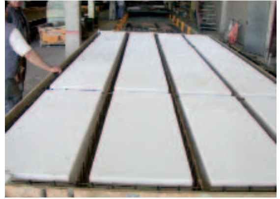
Рис. 3 Элементы из бетона ААС уложены на свежий бетон нижнего уровня.
