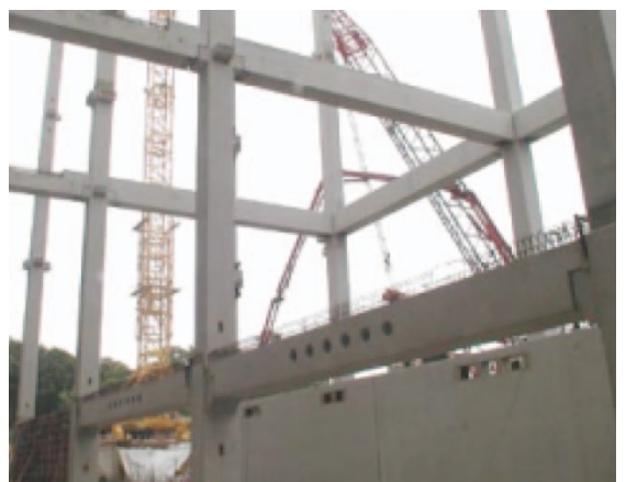
Рис. 10 Узел пространственной конструкции из сборных железобетонных деталей.
