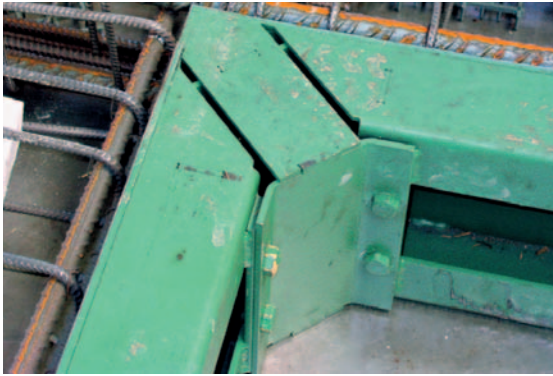
Рис. 8 Опалубка оконного проема вблизи.
