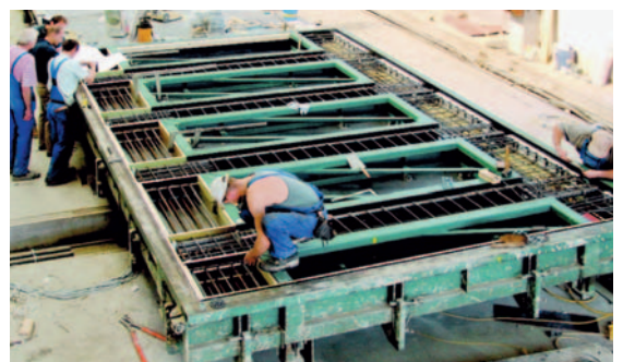
Рис. 7 Специальная опалубка для изготовления элементов фасада на опрокидывающемся столе.
