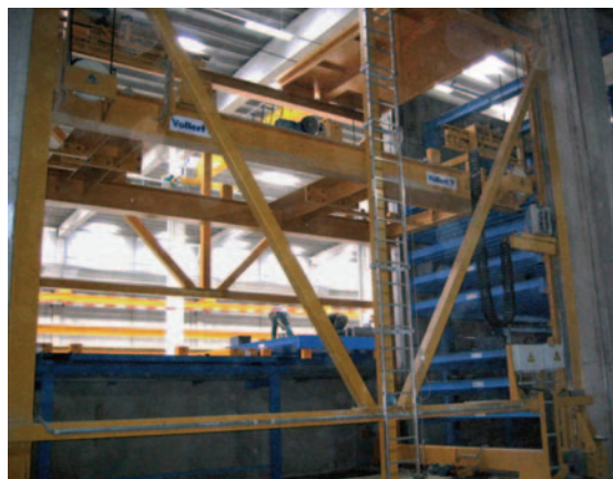
Рис. 5 Установка и удаление поддонов из камеры тепловлажностной обработки бетона с помощью речного устройства.
