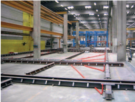
Рис. 2 Крепление и установка встроенных деталей на уже имеющемся полу (слева), бетонирование нового пола (справа).
