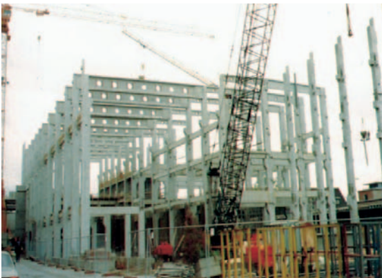
Рис. 12 Бумажная фабрика как пример жесткой конструкции из готовых железобетонных компонентов.
