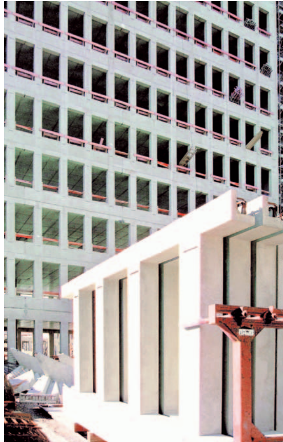
Рис. 9 Уложенные на специальные поддоны готовые панели фасада.
