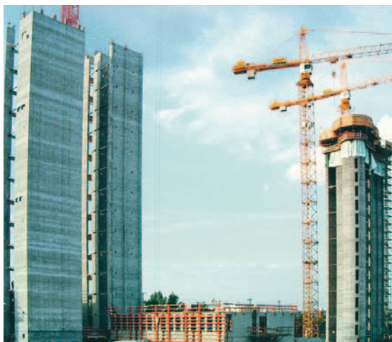
Рис. 3 Опережающее возведение ядер методом скользящей опалубки.
