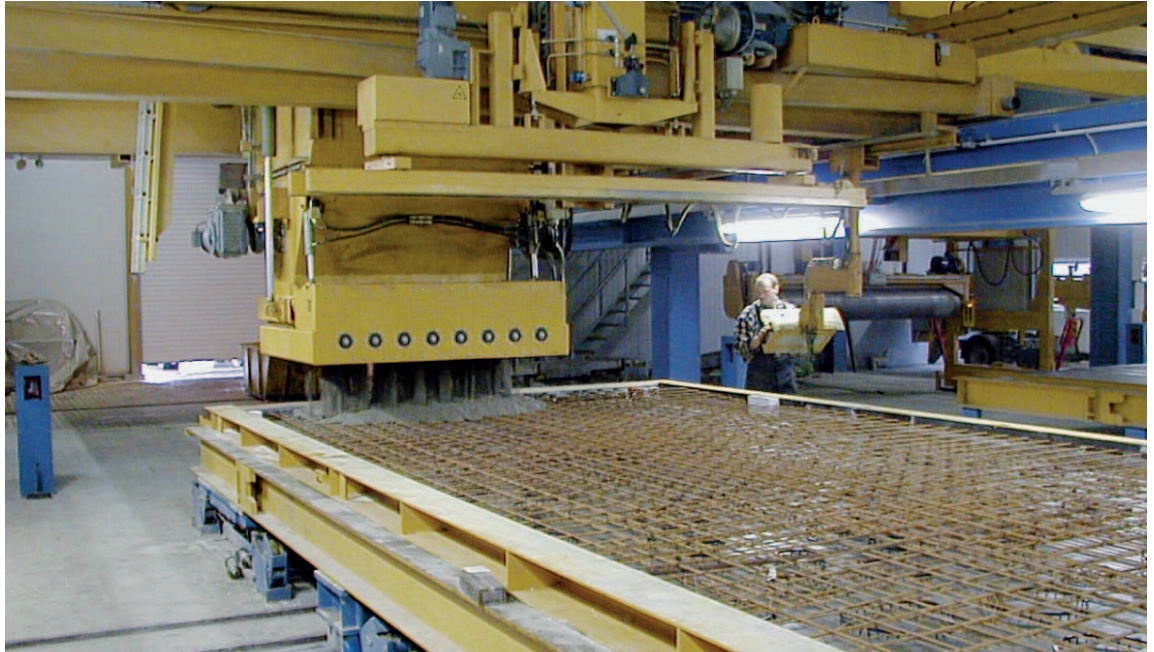
Рис. 3 Участок заливки бетона.
