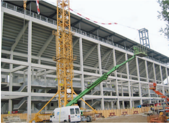
Рис. 11 Несущая конструкция трибуны футбольного стадиона Rhein-Эnergie в Кельне.
