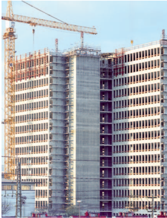
Рис. 5 Перфорированный фасад из готовых железобетонных элементов.
