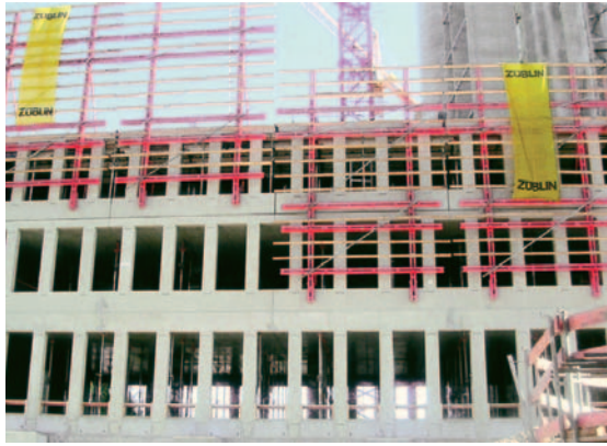
Рис. 10 Перфорированный фасад в опалубке.
