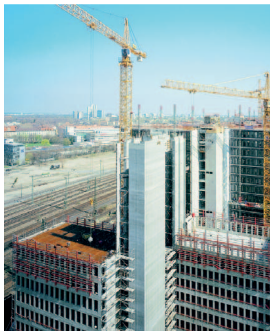
Рис. 4 Строительство этажей с отставанием от ядер.
