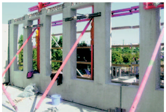
Рис. 11 Монтаж готовых панелей фасада.
