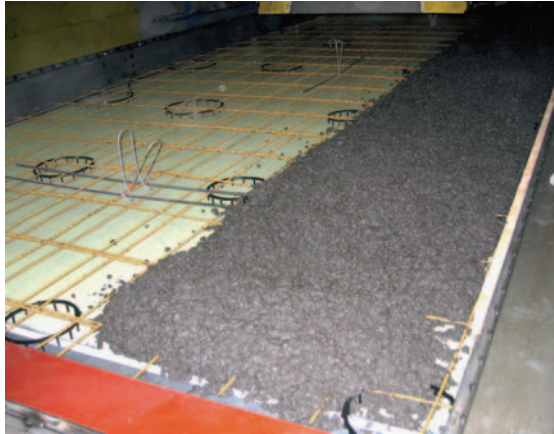
Рис. 6 После установки арматуры в отделочный слой панели происходит бетонирование с использованием декоративного облицовочного бетона и последующее уплотнение с помощью малошумящего оборудования.
