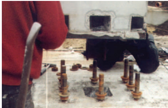
Рис. 3 Фундамент с анкерными болтами и сборные колонны с опорами колонн.
