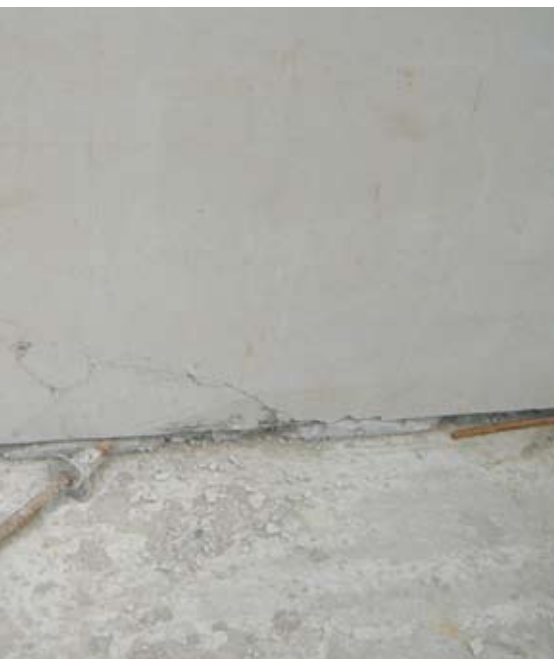
◀ FIG. 2 Broken bottom-left corner // ABB. 2 Abgebrochene linke untere Ecke.
