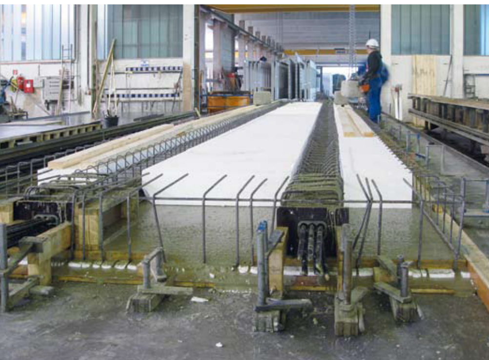
▲ FIG. 1 Arrangement of mono strands for a ribbed floor slab with wide span. // ABB.1 Eingelegte Monolitzen für eine Rippenplattendecke großer Spannweite.
