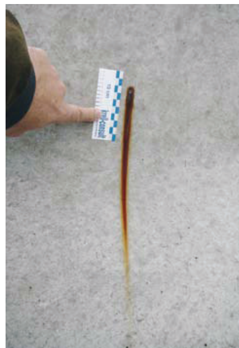
▲ FIG. 2 Pyrite particle on the surface. // ABB. 2 Pyritkorn an der Oberfläche.
