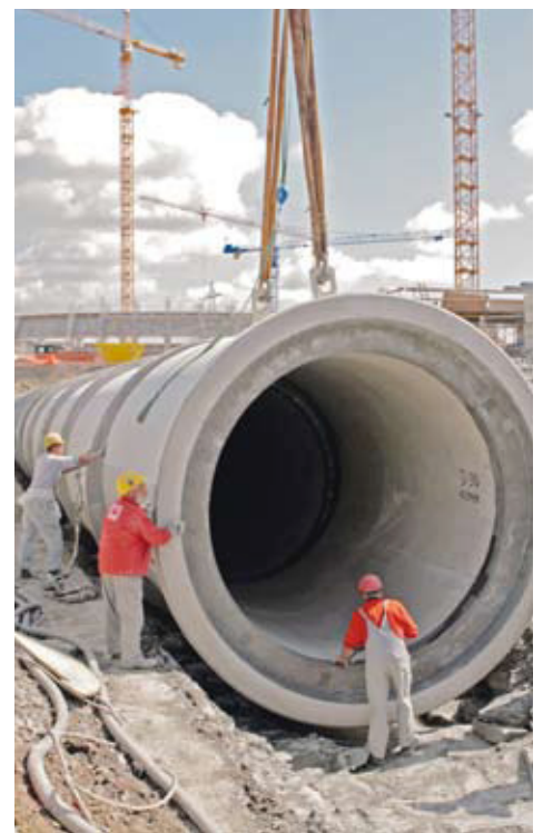
▼ FIG. 2 Prior to erecting the cooling tower, the “giant” pressure pipes were laid according to a specially developed surveying plan, and installed using chain hoists. // ABB. 2 Vor der Errichtung des Kühlturms wurden die „Riesen unter den Druckrohren“ nach einem besonderen Vermessungskonzept verlegt und über Kettenzüge eingezogen.
