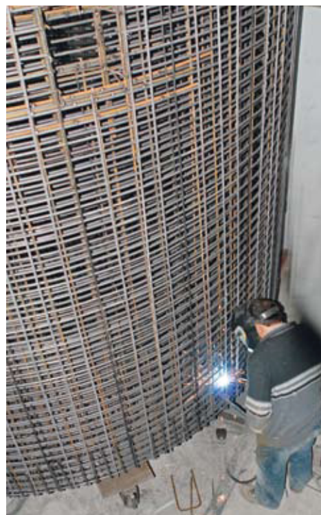
▼ FIG. 1 The 5 m high reinforcement cages weighing 6 tonnes each are welded with “pinpoint” precision at the factory. The complex design and dimensioning and the degree of workmanship called for utmost precision – a prime example of the “art of concrete construction”. // ABB. 1 Die 5 m hohen und 6 t schweren Bewehrungskörbe werden im Werk „punktgenau“ verschweißt. Die Schwierigkeit der Bemessung sowie der handwerklichen Umsetzung verlangen höchste Präzisionsarbeit – ein Beispiel für die „hohe Schule des Betonbaus“.
