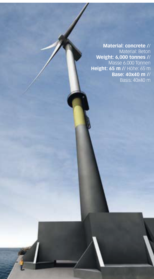
◀ FIG. 1 Assembled turnkey wind turbine prior to sea transport; precast prestressed concrete foundation pad with steel tower, generator and rotor mounted on top. // ABB. 1 Schlüsselfertig montierte Windkraftanlage vor dem Seetransport; Spannbeton-Fertigteil-Fundament mit aufgesetztem Stahlurm, Generator und Rotor.
