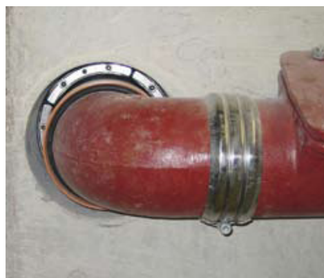
▲ FIG. 1 Rubber compression gasket for pipes // ABB. 1 Gummipressdichtung für Rohre.
