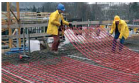
◀ FIG. 2 Water-charged plastic pipes transport heat or cold into the structural concrete components. The heated or cooled wall surfaces create a comfortable indoor climate and living atmosphere. // ABB. 2 Kunststoffrohre, wasserdurchströmt, transportieren Wärme oder Kühle in die Betonbauteile. Die temperierten Wandoberflächen erzeugen ein angenehmes Arbeitsklima und Wohngefühl.
