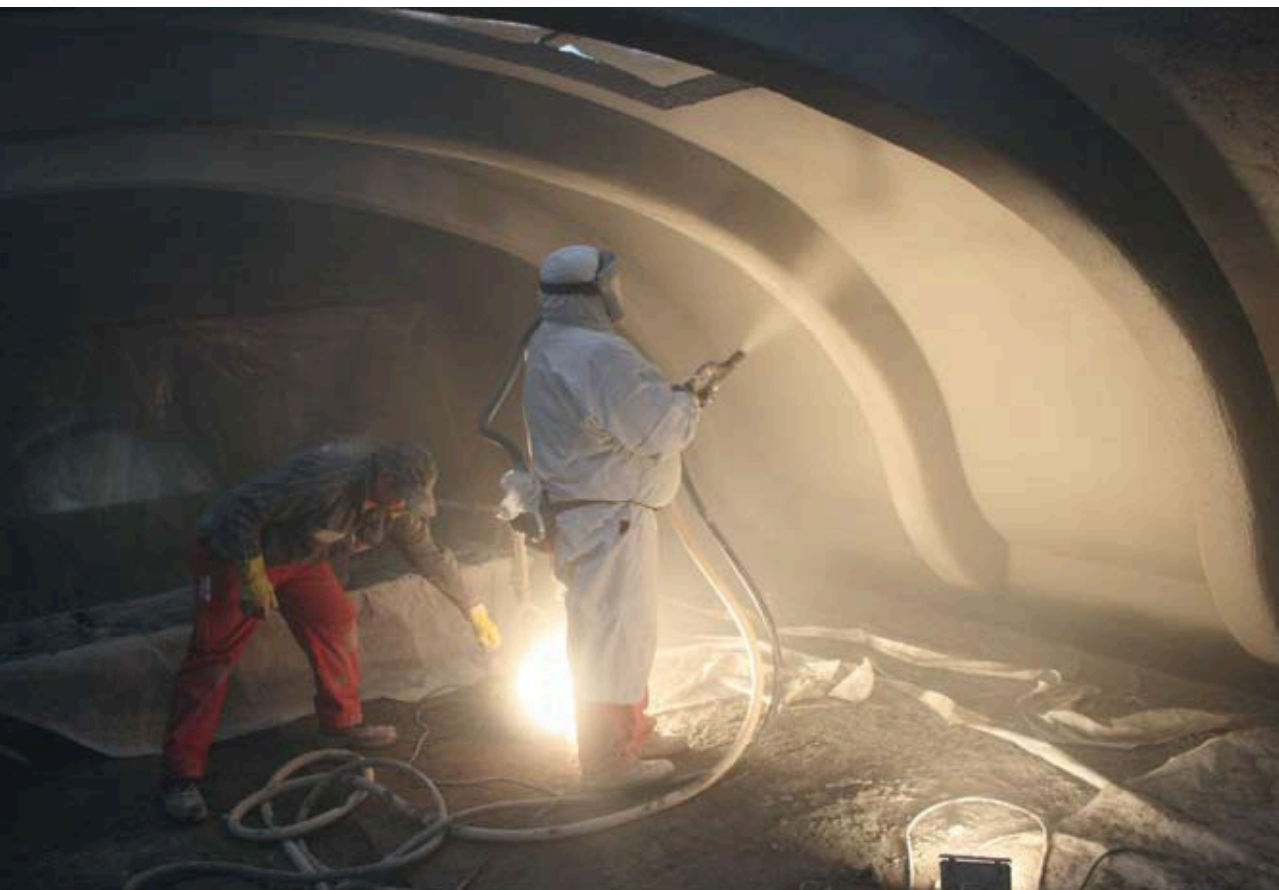
◀ FIG. 2 Reinforcing works on a listed reinforced concrete shell applying textile-reinforced concrete (photo by Silvio Weiland) // ABB. 2 Verstärkungsarbeiten an einer denkmalgeschützten Stahlbetonschale mit Textilbeton (Foto: Silvio Weiland)
