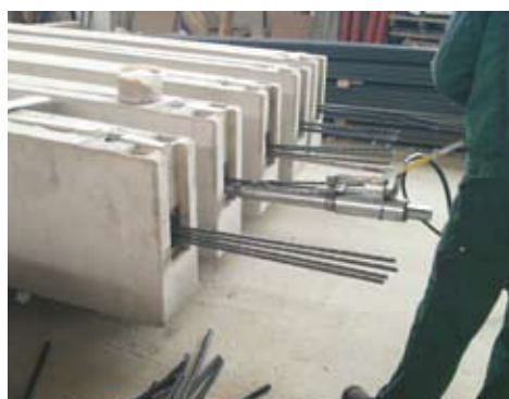
▲ FIG. 2 Application of prestress for precast girders. // ABB. 2 Aufbringen der Vorspannung für Fertigteilbinder.
