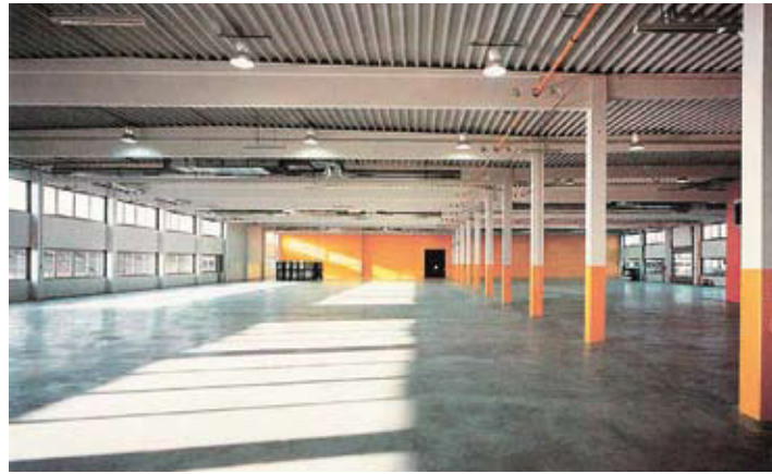
► FIG. 1 Industrial concrete floor in a warehouse. // ABB. 1 Industrieboden aus Beton in einer Lagerhalle.
